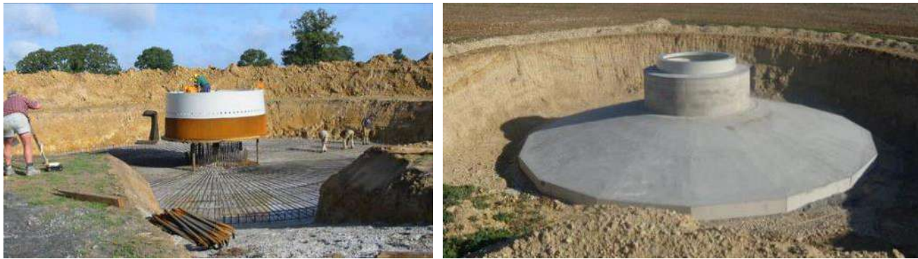
Figure 17 : Le ferrailage et le coulage d'une fondation d'éolienne
