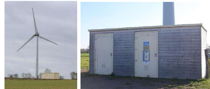
Figure 19 : Exemples de poste de livraison électrique
