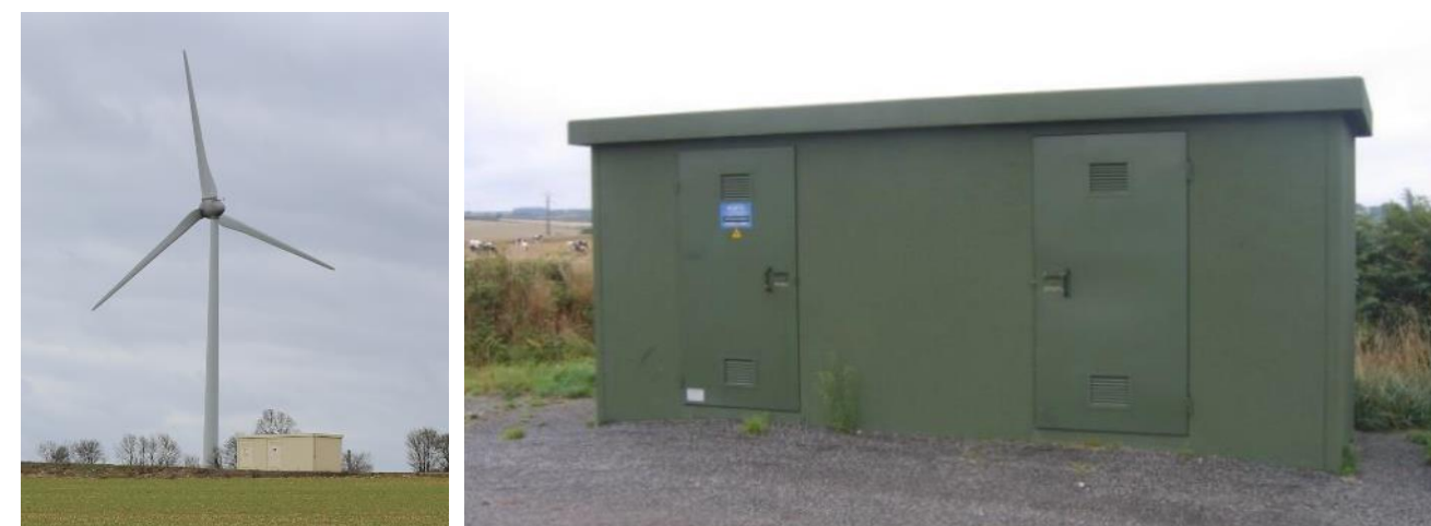
Photo 5 : exemples de poste de livraison électrique
