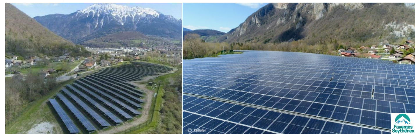
Centrale photovoltaïque (2,5 MWc) implantée sur une ancienne décharge, à Faverges-Seythenex
