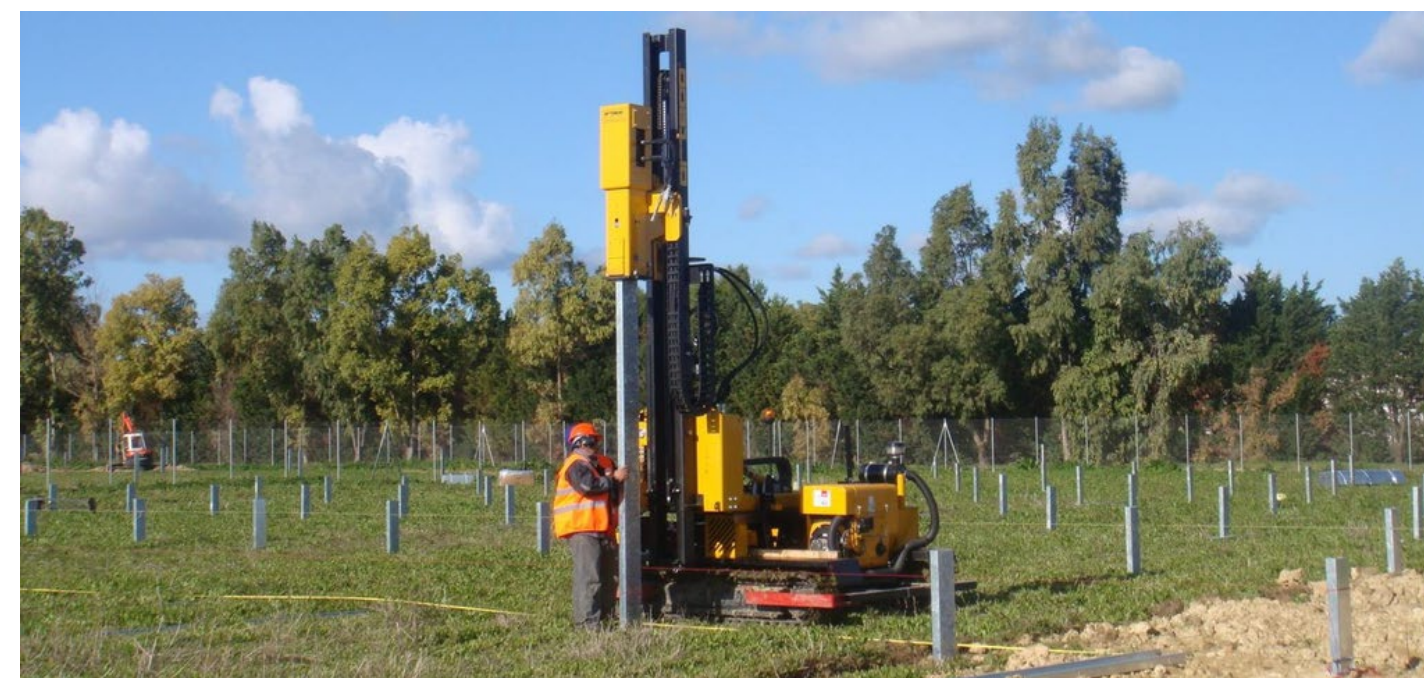
Battage de pieux durant la phase travaux
