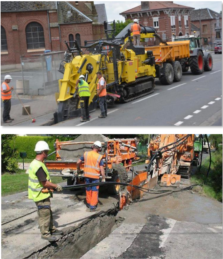
Figure 42 : Illustration d'un passage de câbles électriques sous voirie (Source : La Voix du Nord, Ouest France)
