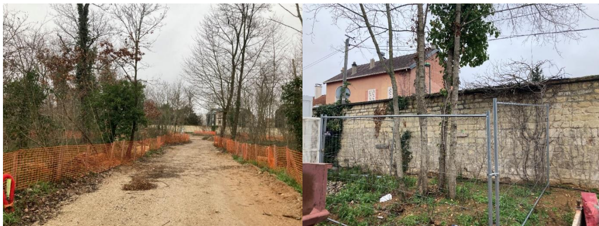
Figure 37 – Balisage des zones à conserver et des arbres à conserver sur un chantier en Ile-de-France, ARP-Astrance 2021
