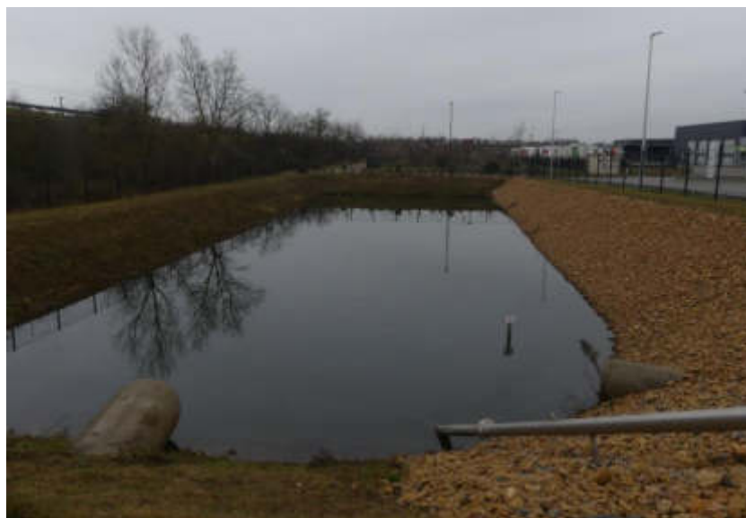
Figure 34 – Enrochement présent sur un bassin étanche d'une plateforme logistique à Pusignan, ARP-Astrance 2022
