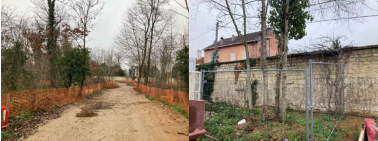
Figure 37 – Balisage des zones à conserver et des arbres à conserver sur un chantier en Ile-de-France, ARP-Astrance 2021
