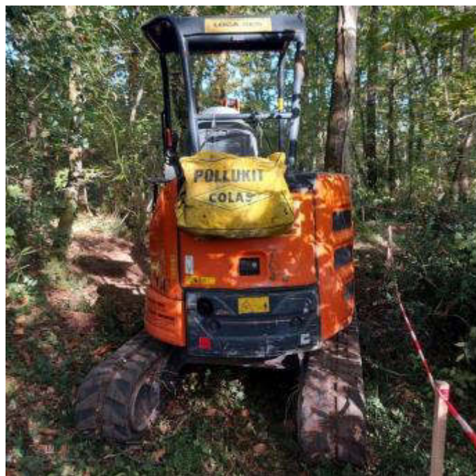
Figure 38 – Kit anti-pollution sur un chantier de mesures compensatoires près d'Angers, ARP-Astrance 2022
