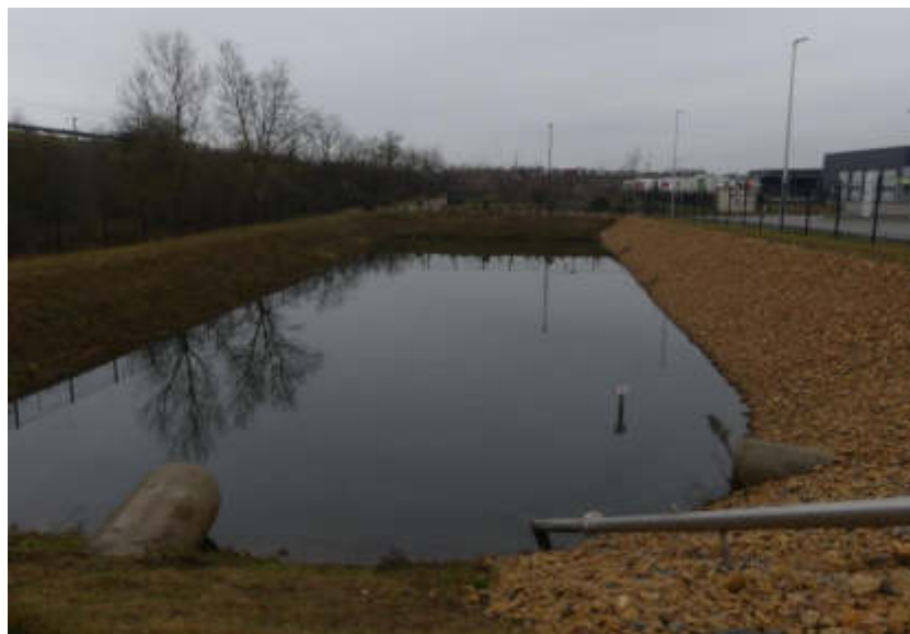
Figure 41 – Enrochement présent sur un bassin étanche d'une plateforme logistique à Pusignan, ARP-Astrance 2022
