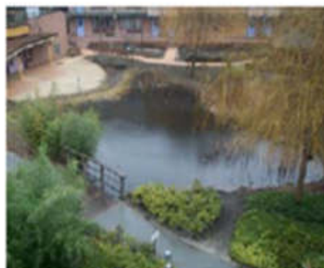
Figure 44 : Marre d'infiltration (Rombaut, 2010)
