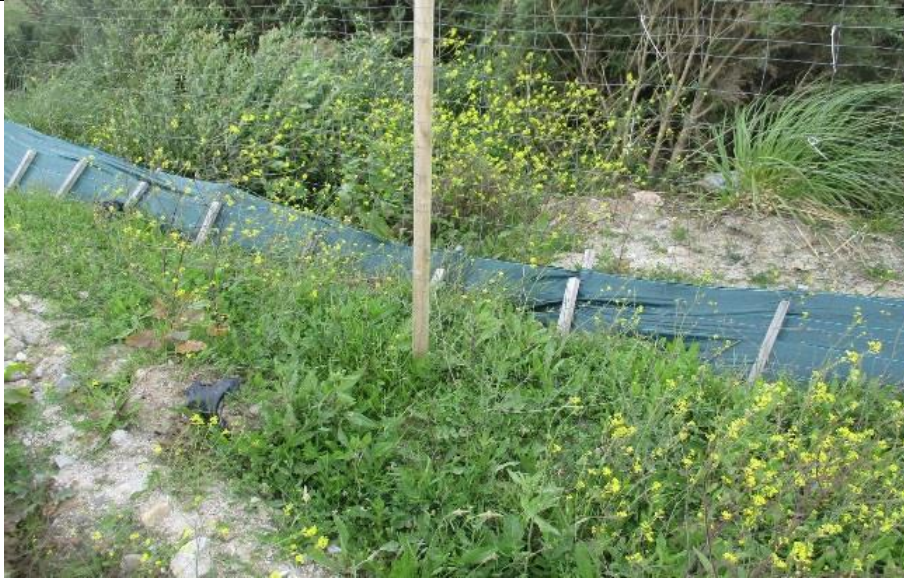
Figure 46 – Barrière anti-retours. Source : SAFEGE, projet du Port de Brest
