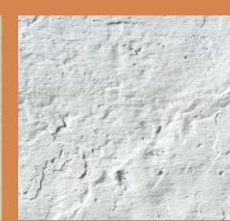
Badigeon au lait de chaux
