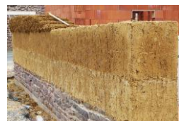
Mur en baugé en cours de construction
