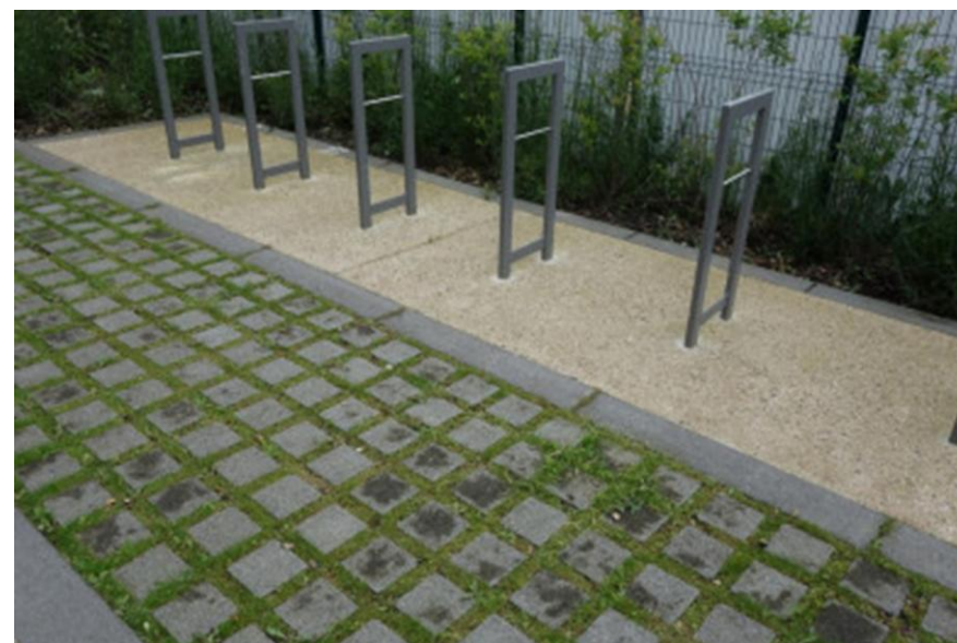
Principe de revêtement perméable
