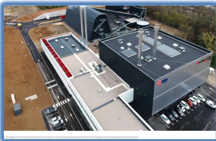
©la 1ère chaufferie de la métropole de Lyon avait été inaugurée en 2019 dans le quartier de gerland
