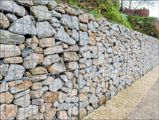
Muret en pierres
