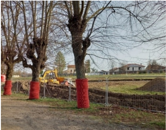
Figure 59 : Exemple de clôture fixe et de protection physique du tronc à mettre en place, S. Chaudet © EODD, 2022
