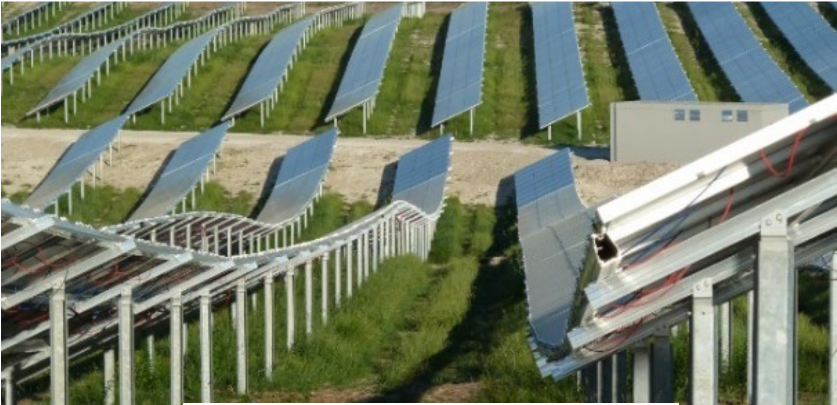
Les structures photovoltaïques s'adaptent à la topographie (crédit photo : Ectare)
