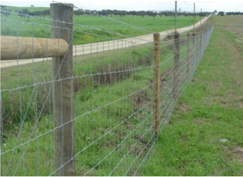
Exemple de clôture rurale perméable à la petite faune (crédit photo : Ectare)
