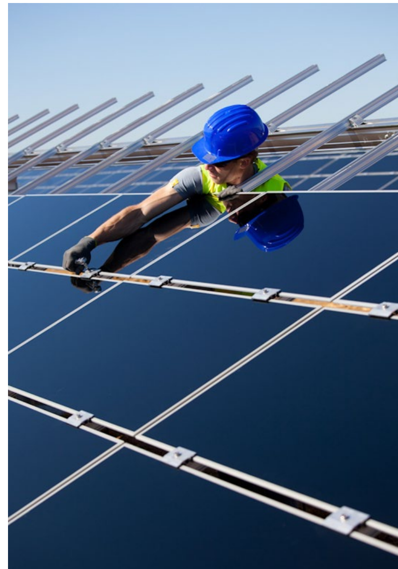
Remplacement de module (crédit photo EDF Renouvelables)
