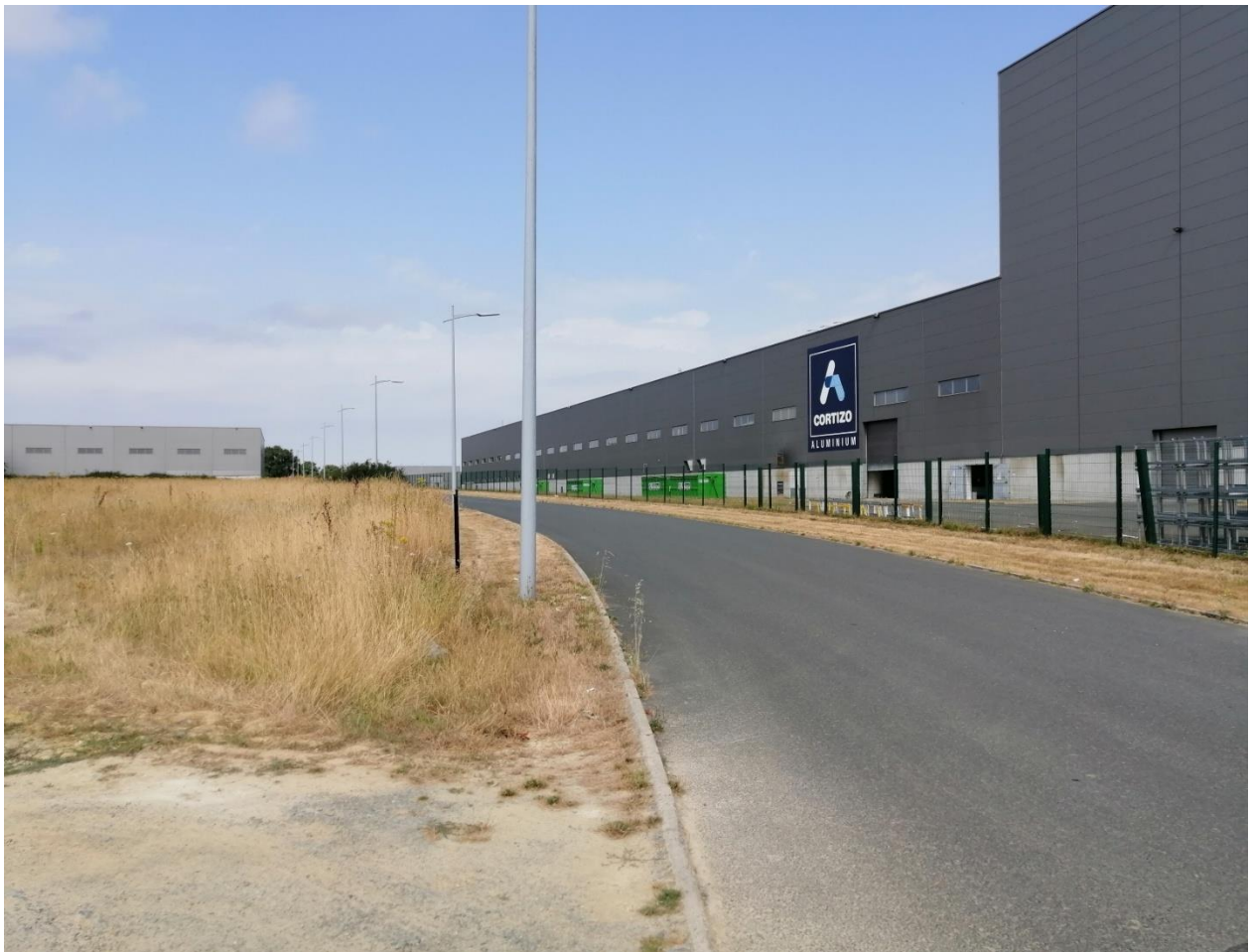
Vue du terrain de l'extension et du bâtiment à démolir (à gauche)
