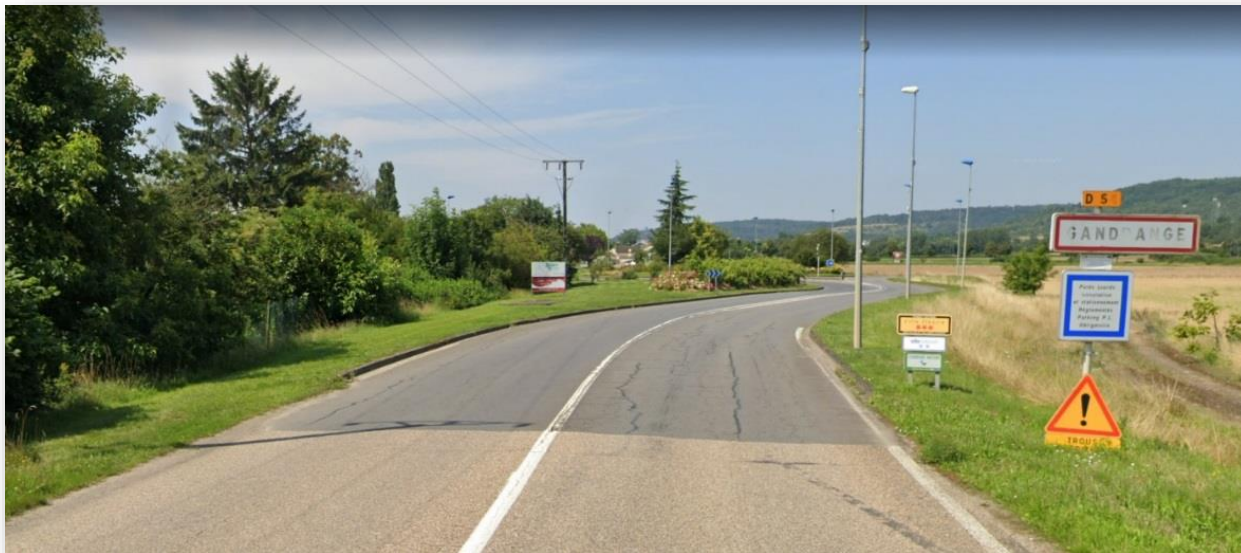
Entrée est de GANDRANGE, (Source : GoogleStreetView)
