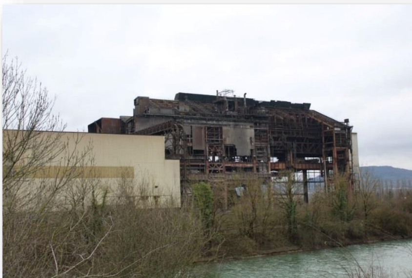
Site industriel ArcelorMittal de GANDRANGE-Rombas (Source : ESTERR)
