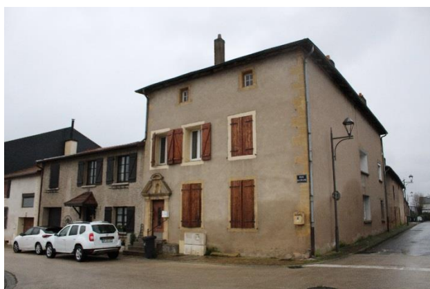
Ferme Lorraine, dans l'ancien centre de Boussange et sa façade latérale (Source : ESTERR)
