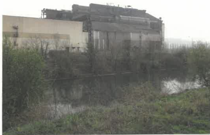
Aciérie située à proximité du village sur la rive opposée (sud) de l'Orne. Usine en cours de démolition au cours du printemps 2022
