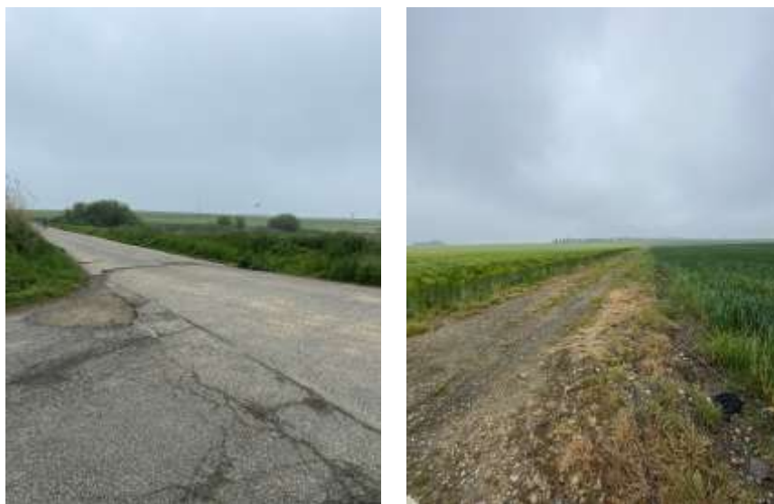
Fossés et chemins menant aux exploitations agricoles à Saint-Pathus, 5 mai 2026, VERDI (chemin du tillet à gauche et chemin perpendiculaire à la D9E1 à droite)
