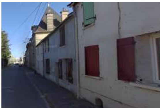
Alignement du bâti le long de la Grand Rue
