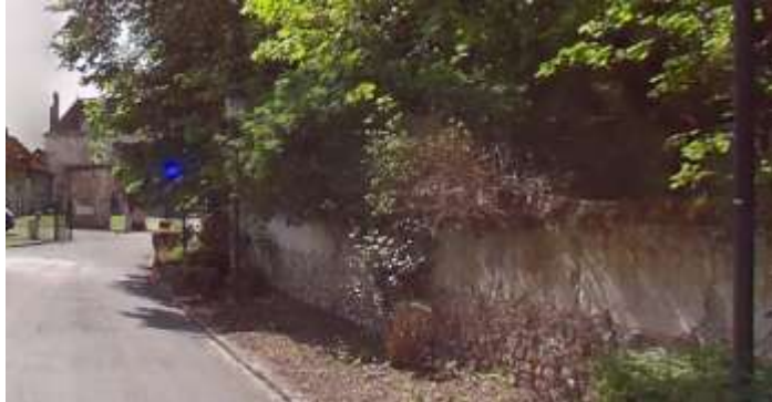
Mur le long de la rue de l'Eglise
