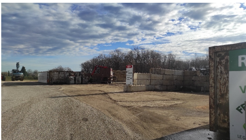
Figure 14 : photographie coté fer/métaux/VHU : alvéoles de stockage des éléments métalliques Zone B
