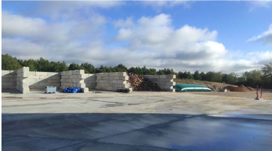
Figure 12 : photographie coté déchetterie pro : alvéoles de stockage et citerne incendie zone B
