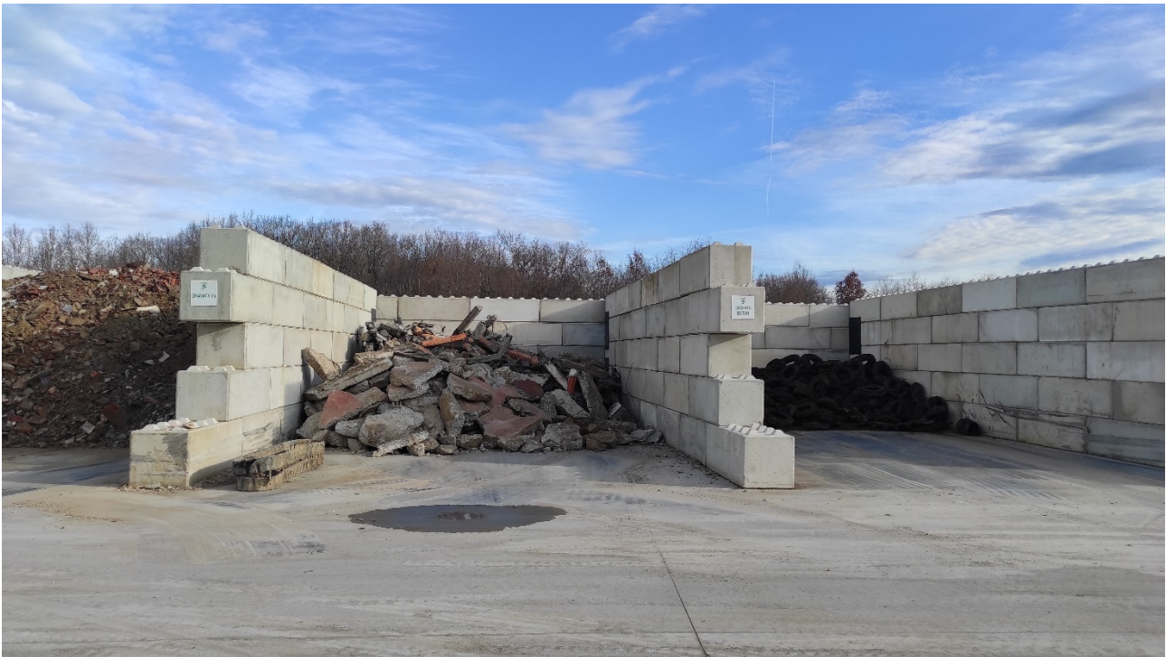
Figure 17 : Photographie des alvéoles de stockage de déchets.
