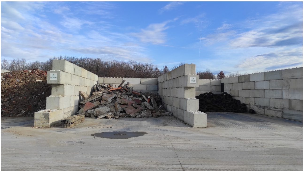
Figure 13 : photographie coté déchetterie pro : alvéoles de stockage Zone B
