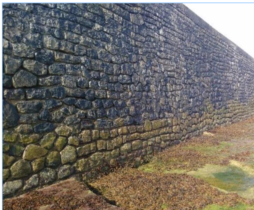
Figure 43 : Exemple de mousse ayant prit place sur la face supérieure de risberme et sur la partie basse de parement
