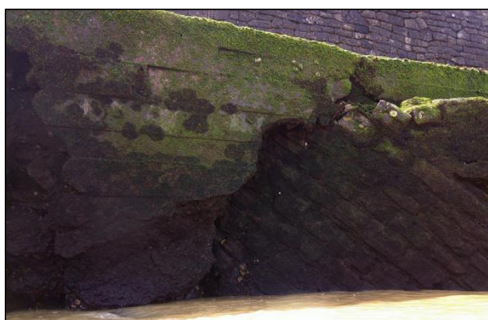
Figure 49 : Cavité observée en sous-œuvre de risberme par les plongeurs
