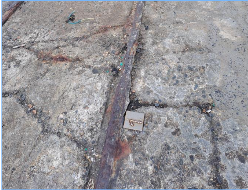
Figure 47 : Exemple de fissures observables au niveau du musoir
