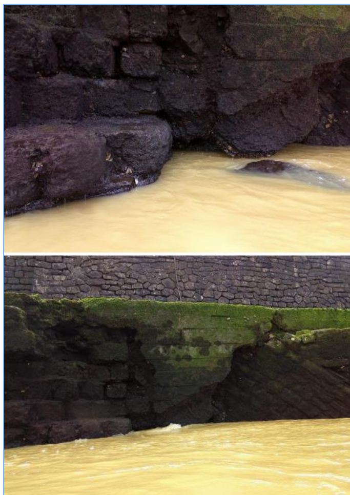
Figure 41 : Photos de désordres de la risberme au droit de la cavité n°3 [source EuroDive]
