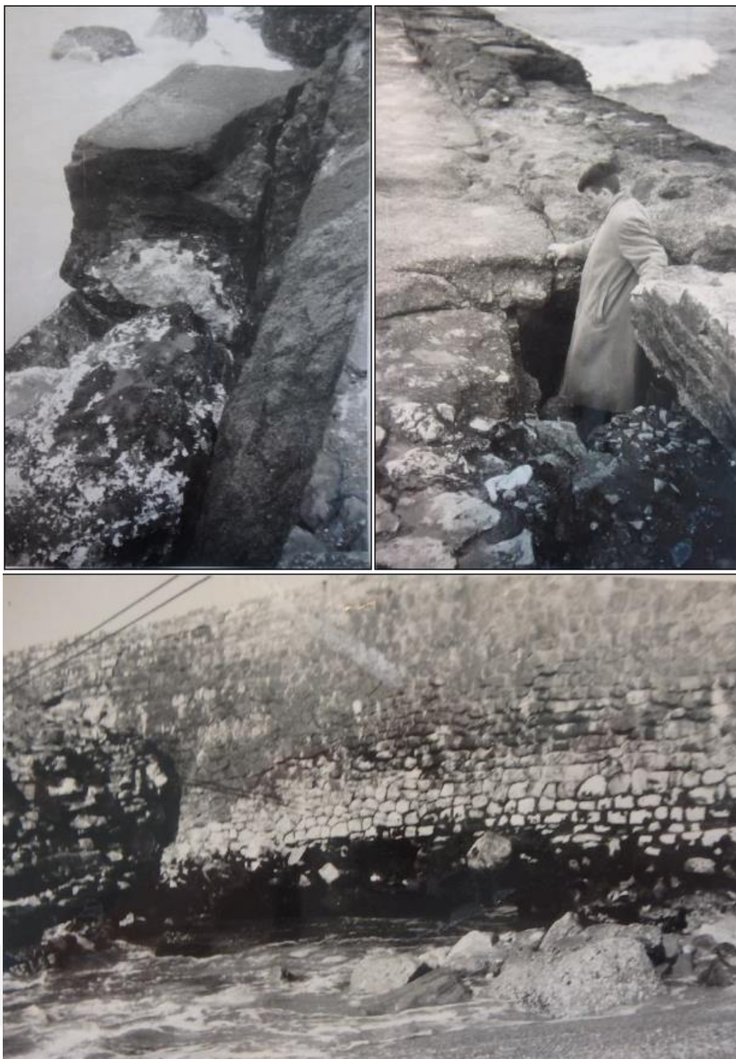
Figure 16 Photographies des désordres sur la jetée Sud, à la suite de la tempête du 14/12/1958
