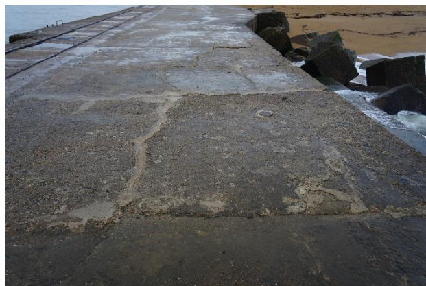
Figure 75: Fissures réparées sur la jetée (photo Safege septembre 2024)
