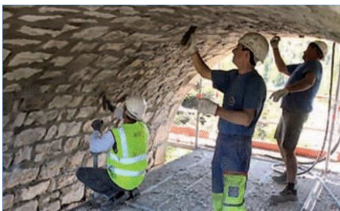
Figure 70: Finition à la brosse au pont des Abarines (crédit photo CG du Gard)
