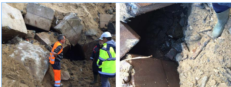
Figure 39 : Cavité observée lors des travaux de terrassement réalisés en 2016 [source BTPS]
