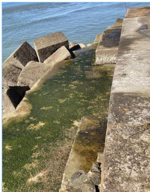
Figure 117 : Risberme de la façade côté plage du musoir ([source Suez Consulting])
