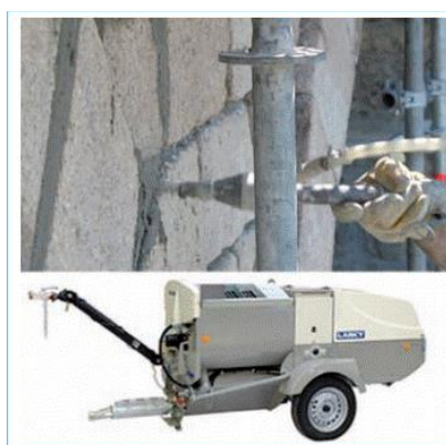
Figure 71: Remplissage des joints au moyen d'une buse par la voie mouillée basse pression (crédit photo CG du Gard)
