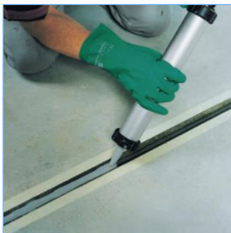
Figure 77 : Rejointoiement à l'aide d'un pistolet à boudin manuel [source PCI]
