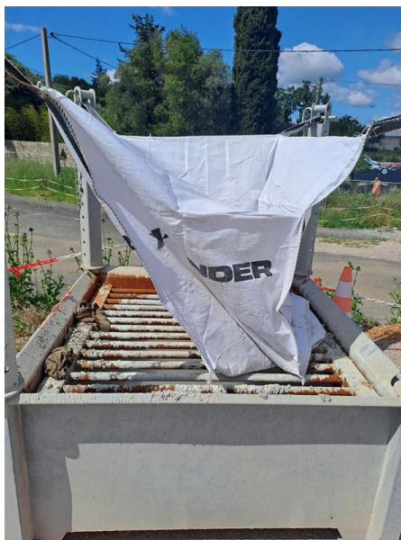
Figure 81: Benne de nettoyage des outils en contact avec le béton
