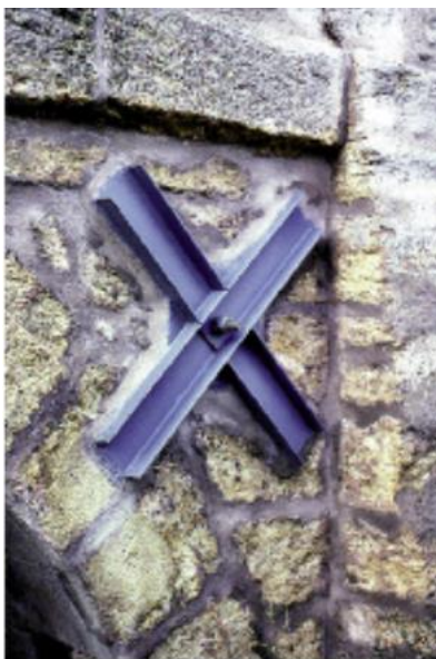
Figure 118 : tirant d'enserrement avec tête d'ancrage en croix de Saint-André. La protection de l'extrémité de la barre n'est pas assurée (crédit photo J.L. Michotey, Guide FABEM 6.3)
