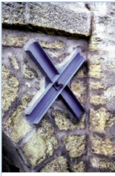
Figure 55 : tirant d'enserrment avec tête d'ancrage en croix de Saint-André. La protection de l'extrémité de la barre n'est pas assurée (crédit photo J.L. Michotey, Guide FABEM 6.3)
