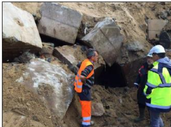
Figure 19 Etat de l'arrière de la jetée Sud au niveau de la zone d'intervention n° 1 correspondant au PM 150 – source : DOE
