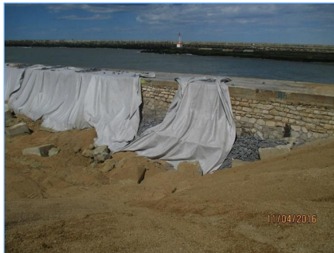
Figure 18 : Photo travaux de pose de géotextile côté plage réalisés en 2016
