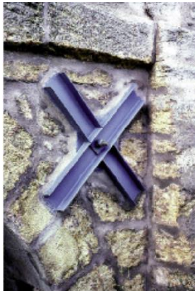
Figure 25 : tirant d'enserrement avec tête d'ancrage en croix de Saint-André. La protection de l'extrémité de la barre n'est pas assurée (crédit photo JL. Michotey, Guide FABEM 6.3) – Source : Dossier AVP SUEZ Consulting
