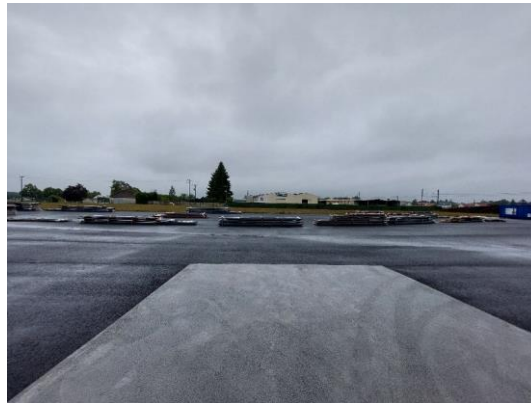
Photo 3 : Zone de stockage extérieur
