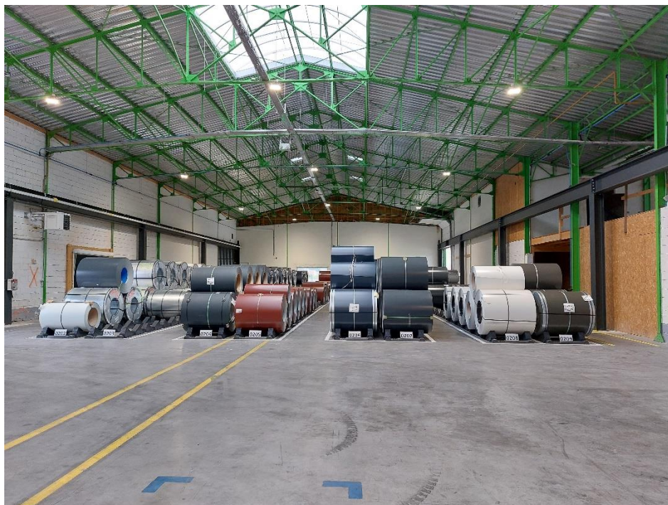
Photo 1 : Zone de stockage actuelle des bobines acier sur le site de Baule
