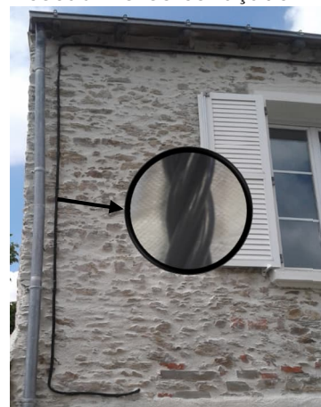
Réseau fils isolés façade BT
