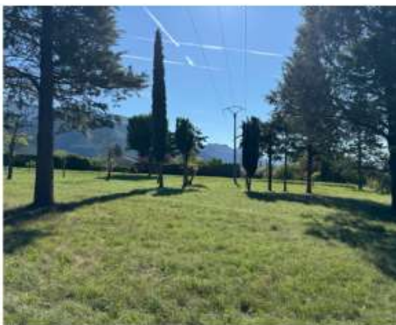
Infrastructure électrique en surplomb de la parcelle
