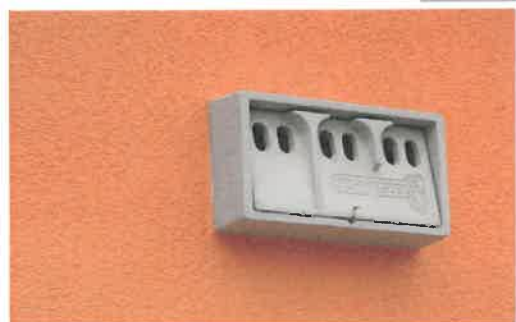
Nichoir à moineaux encastré dans l'isolation extérieure
