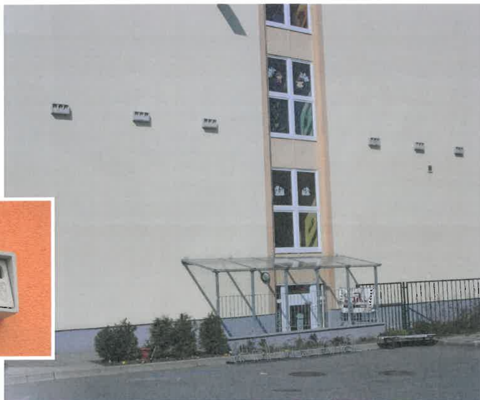
Nichoir à moineaux encastré dans l'isolation extérieure
