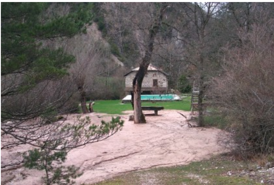
Maison menacée (Taravel) par l'avancée de la coulée
