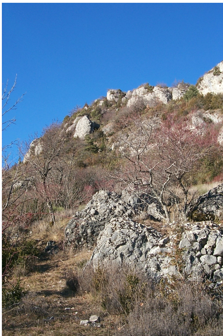
Chutes de blocs au niveau des falaises surplombant Ravel
