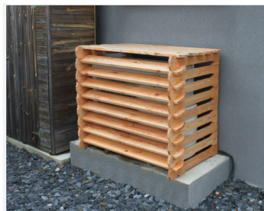
Exemple de traitement pour les échangeurs de climatiseurs.
