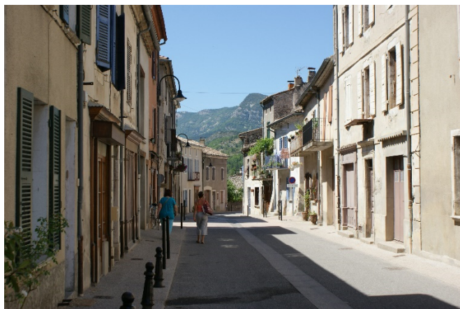
Structure urbaine historique de faubourg
