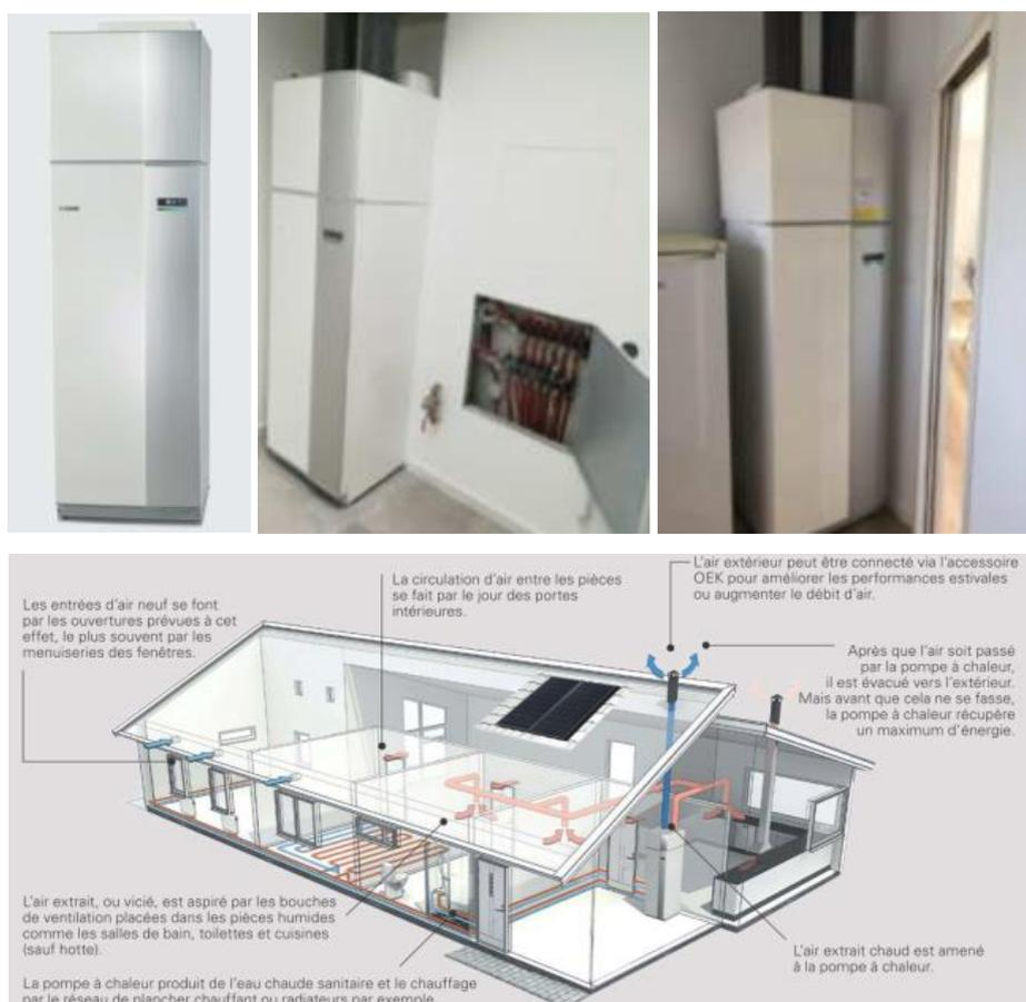
Il est possible d'intégrer ces unités pour du logements collectifs. En effet, le rejet de ces unités peut se raccorder sur un réseau collectif double peau avec rejet en toiture
