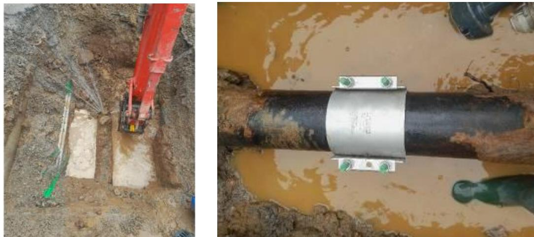
11/09/2023 Réparation sur conduite PVC collé diamètre 50 passant au milieu d'un terrain privé Kerlan route de Plaudren à Elven.
