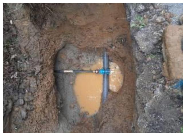
20/07/2023 Fuite sur bride antifluage posée lors du renouvellement de la conduite Elven/Monterblanc au carrefour du Cosquer à Elven
