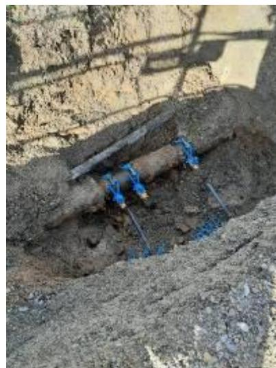
25/01/23 Fuite sur cana PVC 90 au niveau du pont de Kercointe à Elven, écoulement d'eau sur la 2x2 voies, fuite au niveau de la jonction PE/PVC
