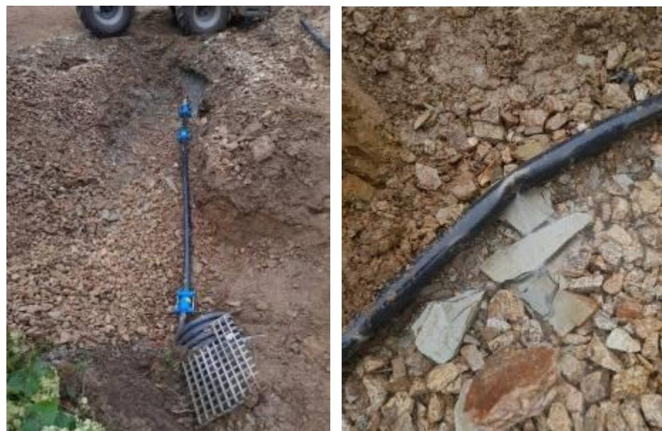
11/10/2023 Fuite sur bride anti fluage posée lors des travaux de renouvellement de la conduite Elven/Monterblanc.
