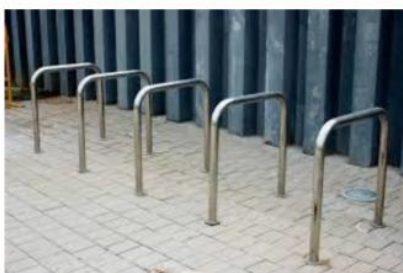
1 arceau = 2 vélos Hauteur : 0.80 mètre Largeur : 0.45 à 1 mètre Diamètre du tube : 5 cm max Espace entre 2 arceaux ou entre mur et arceau : 0.60 mètre
