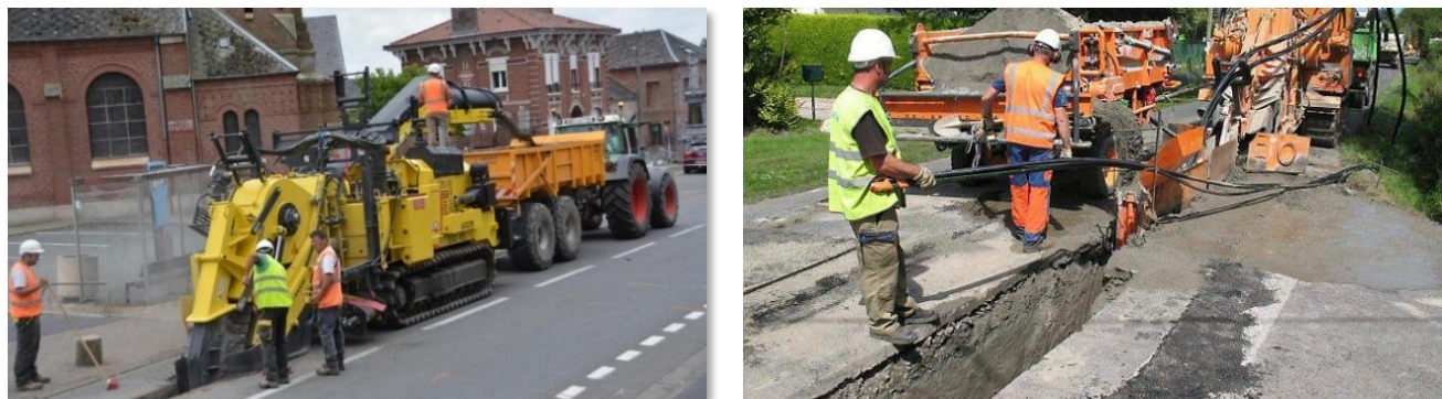
Figure 3 : Illustration d'un passage de câbles électriques sous voirie (Source : La Voix du Nord, Ouest France)
