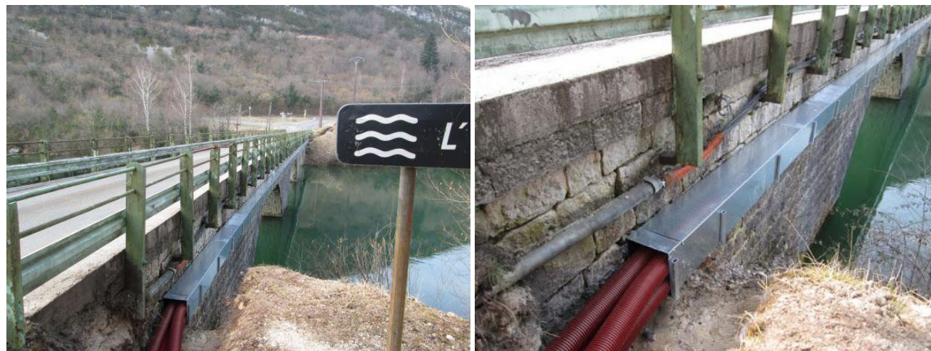
Figure 9 : Exemple d'un passage de câbles HTA en encorbellement d'un ouvrage existant (Source : Tattu TP)
