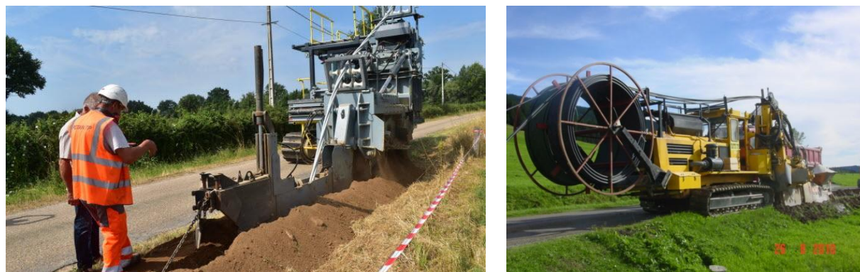
Figure 13 : Exemple de trancheuse en action (Source : Le Journal de Saône et Loire ; Tattu TP)
