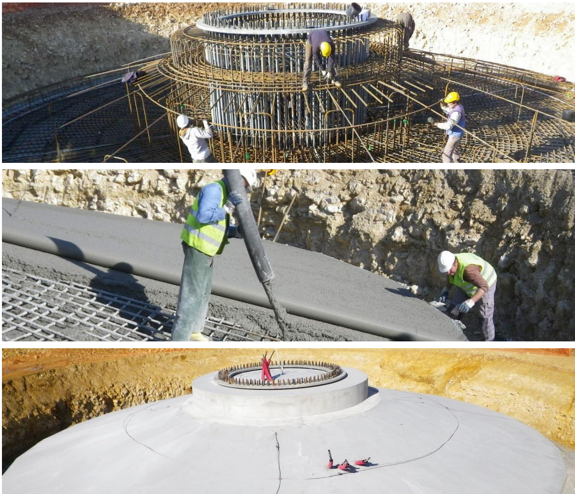
Figure 17 : Les étapes de construction d'une fondation pour une éolienne NORDEX (Source : NORDEX)
