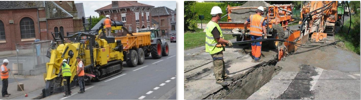
Figure 47 : Illustration d'un passage de câbles électriques sous voirie (Source : La Voix du Nord, Ouest France)
