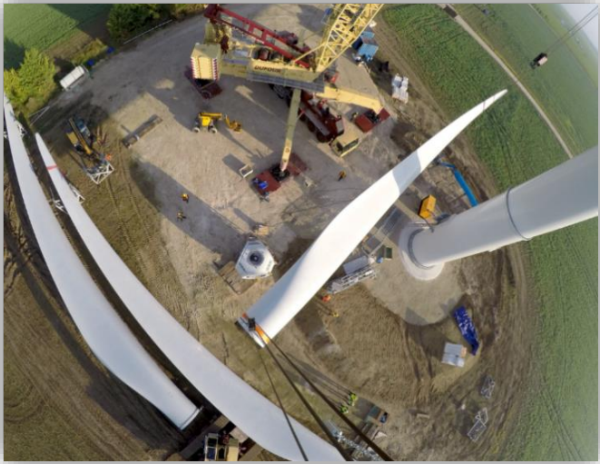
Figure 31 : Vue sur une plateforme de montage depuis la nacelle (Source : NORDEX)
