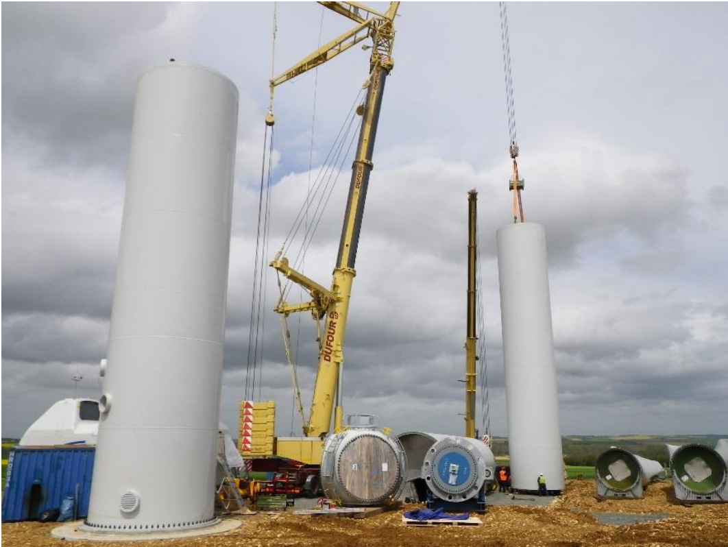
Figure 18 : Portion de mât acier pour une éolienne NORDEX (Source : NORDEX)
