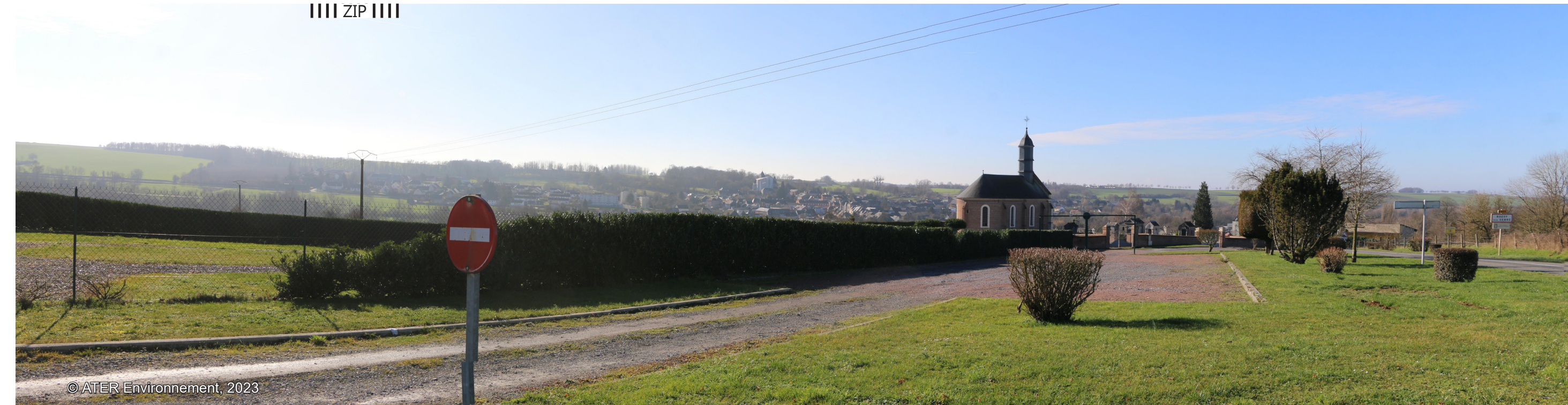
Fig. 42 : Vue sur Rozoy-sur-Serre depuis le nord-est du bourg
