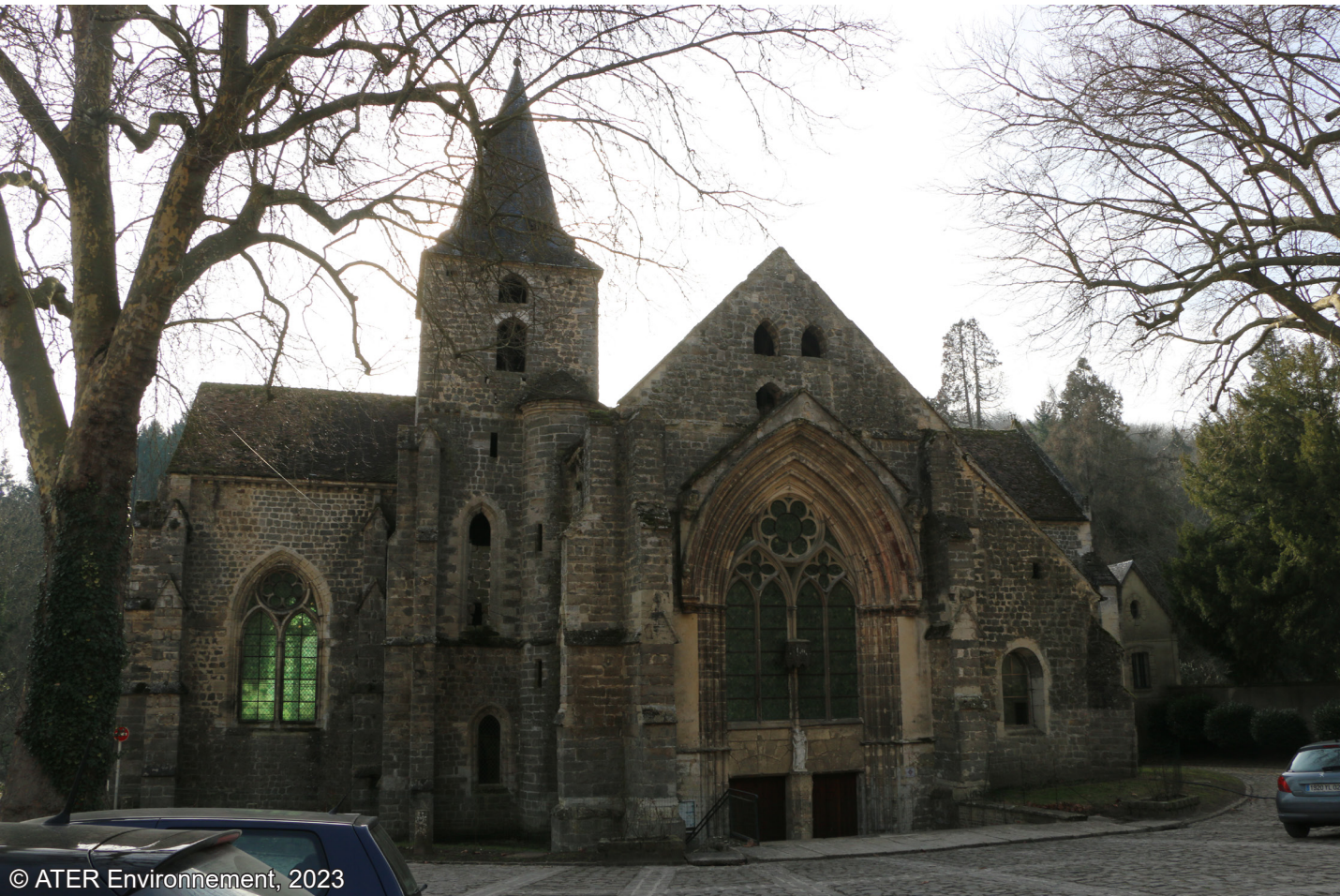
Fig. 64 : Eglise classée à Montaigu, au sud-ouest de l'aire d'étude
