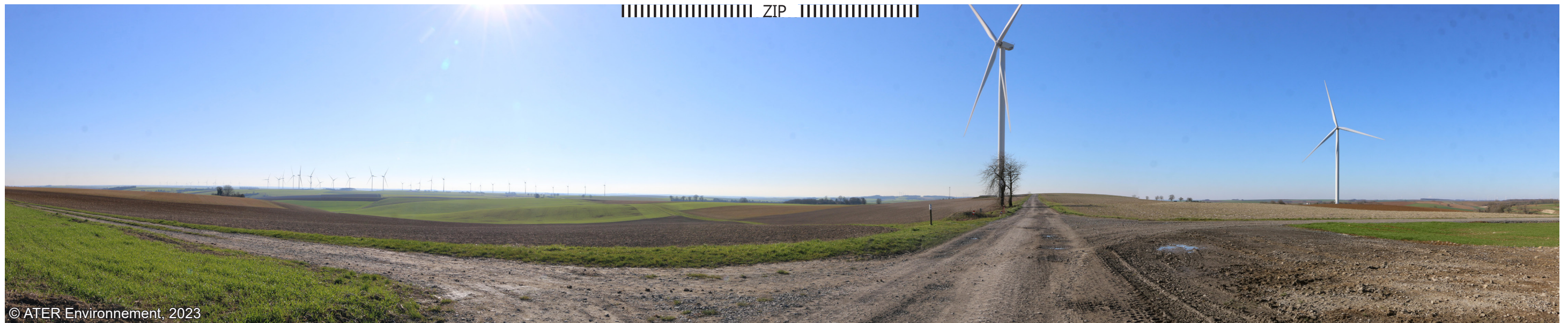
Fig. 25 : Au croisement entre les GR à l'est de l'aire d'étude rapprochée. Au premier plan, le parc de Chappes-Remaucourt.
