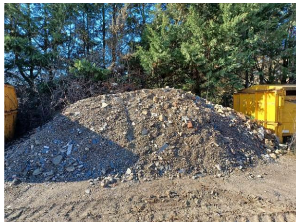
Stockage de gravats
