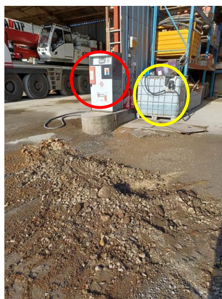
Poste gasoil (rouge), localisation de la cuve enterrée de gasoil (orange) et de la cuve aérienne d'AD BLUE (jaune)
