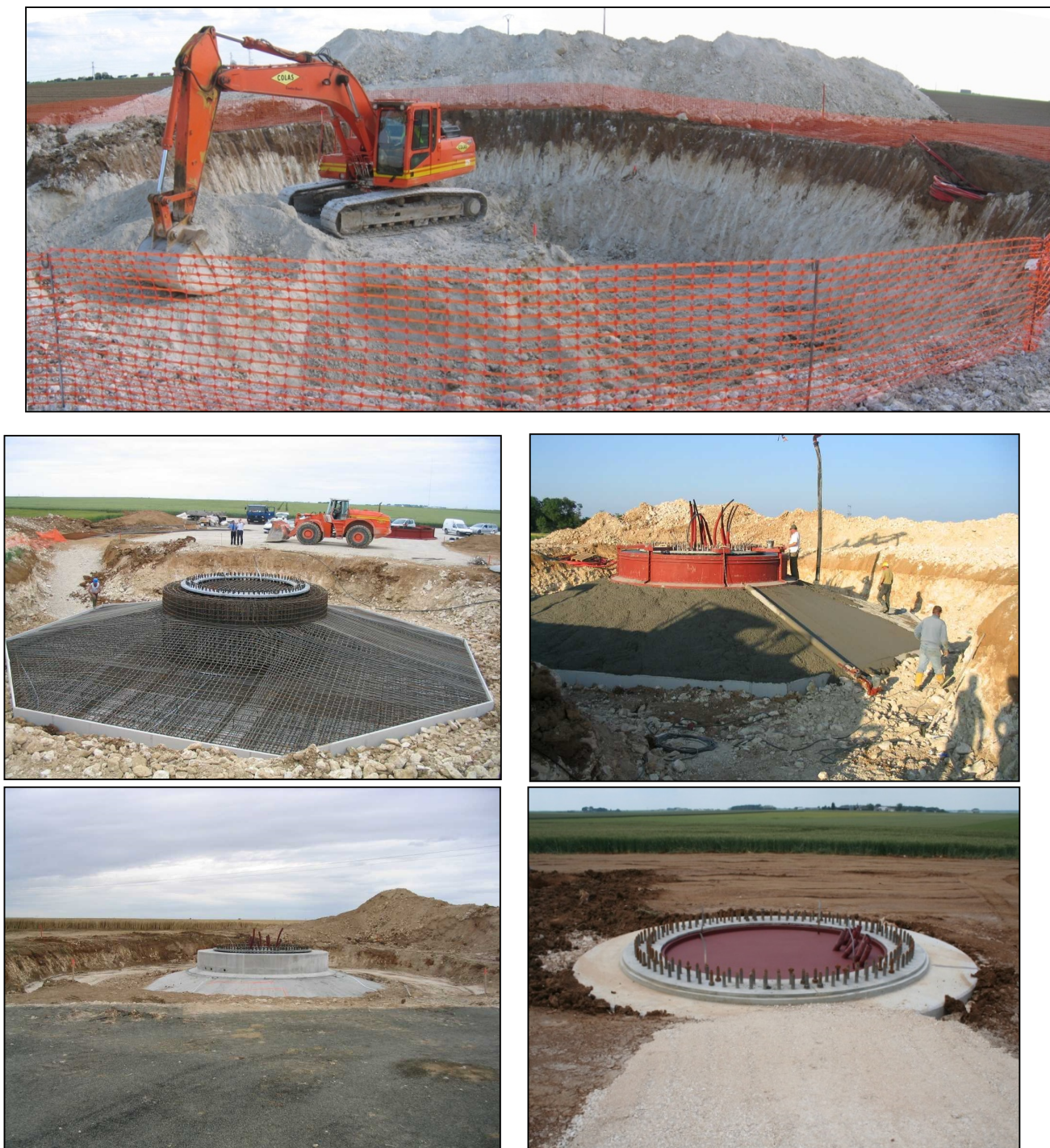
Figure 14 : Photos illustrant les étapes de la réalisation d'une fondation – Source : NORDEX
