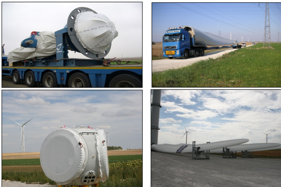
Figure 15 : Photos illustrant l'acheminement et le stockage des éléments des éoliennes – Source : NORDEX
