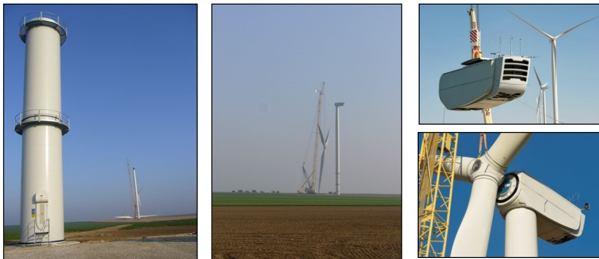
Figure 17 : Photos illustrant le montage d'une éolienne – Source : NORDEX
