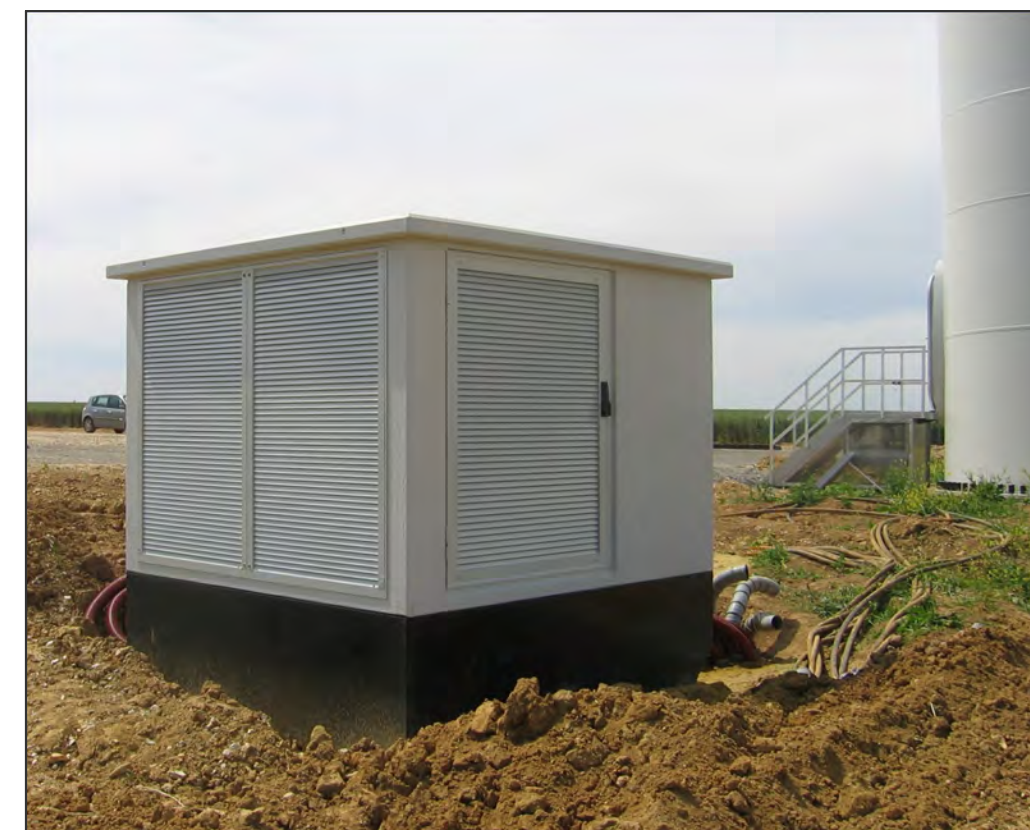
Exemple d'une sous-station au pied d'une éolienne
