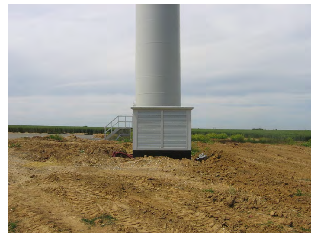
Exemple d'une sous-station au pied d'une éolienne
