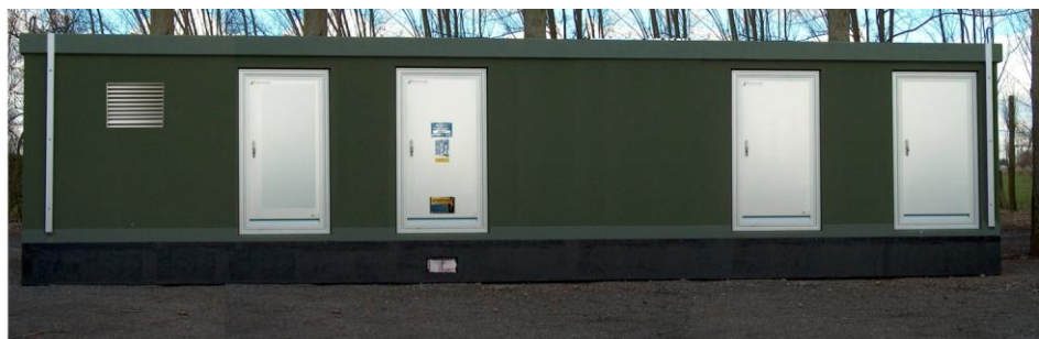
Photographie 2 : exemple de poste de livraison brut
