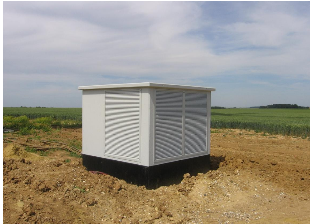
Figure 30 : exemple de sous-station de transformation
