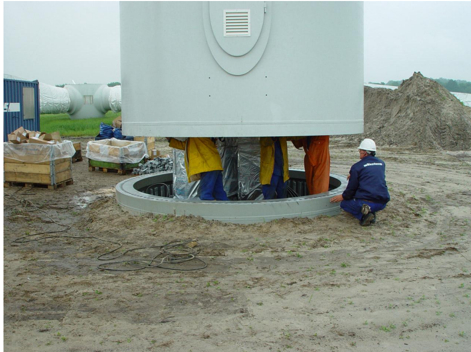
Photographie 9 : Montage du mât sur la fondation
