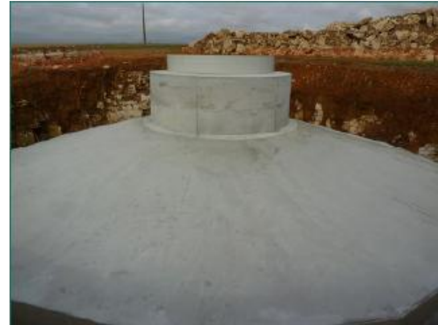
Photographie 6 : Fondation après coulage béton (source : Volkswind)
