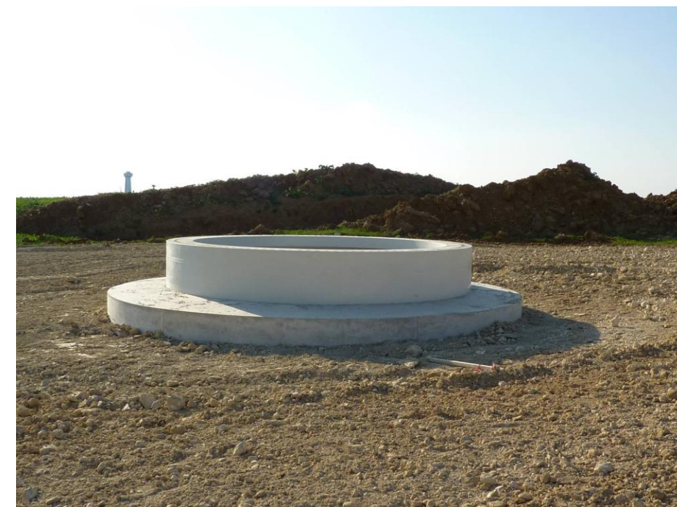
Photographie 7 : Fondation après remblaiement (source : Volkswind)
