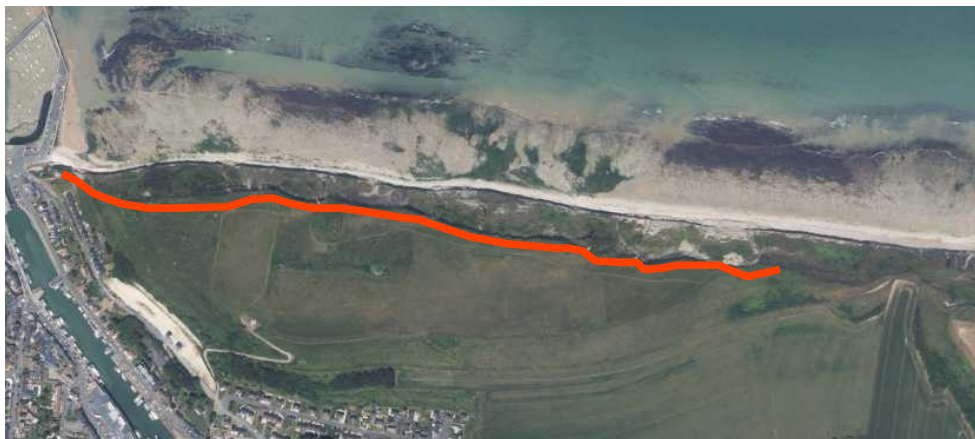
Figure IV.3: Site 2 : zone de surveillance topographique.
