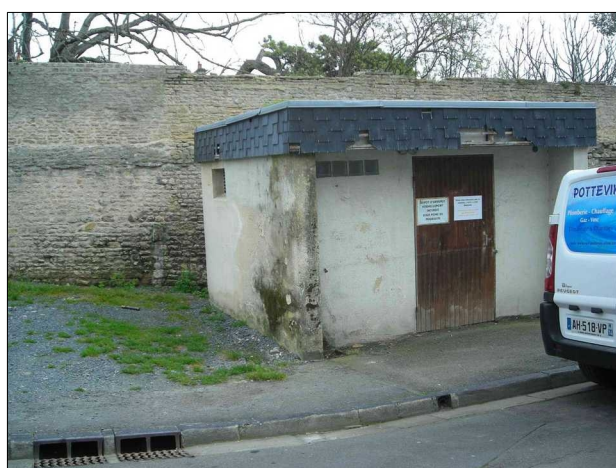
Figure 56: ancien transformateur électrique incliné de la rue du Nord (construction depuis déplacée).
