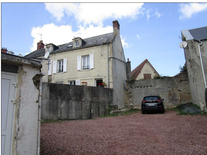
Figure 14: ancien emplacement de la "maison qui penche" devenu un parking (photographie de juin 2023). En arrière plan deux constructions sont sévèrement fissurées.
