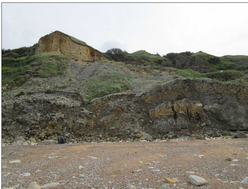
Figure 8: glissement du Bouffay de 2018 ayant emporté deux escaliers d'accès à la plage.
