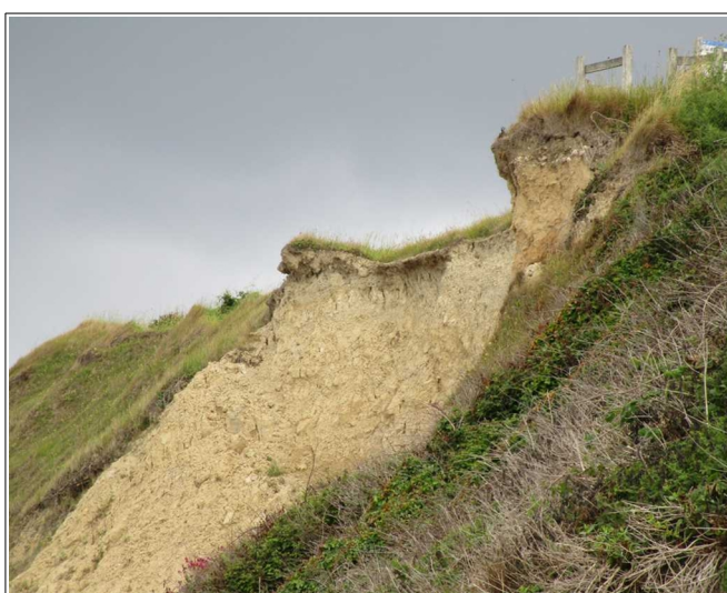
Figure 20: glissement de terrain au niveau de la Tour Vauban (niveau de marne concerné).
