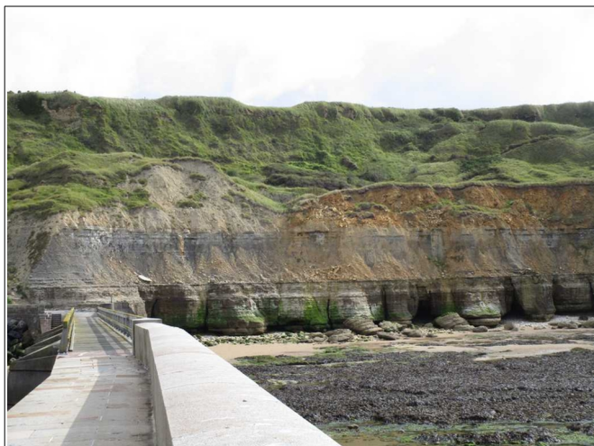
Figure 31: exemple d'érosion possible par les vagues lors de tempête (au-dessus de la falaise inférieure).
