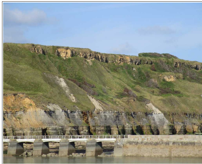
Figure 28: vue générale du talus côtier à l'ouest du port de Port-en-Bessin. On distingue des mouvements de terrain de la partie sommitale et des glissements de terrain superficiels de la partie intermédiaire.
