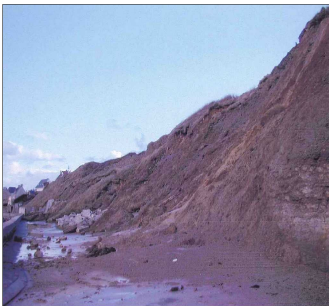
Figure 11: glissements de terrain superficiels de 1999 ayant atteint le chemin des Tourettes.
