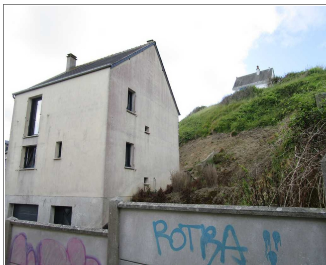
Figure 35: terrain remis en état et maison réhabilitée en 2023.
