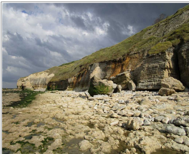
Figure 47: blocs effondrés sur eux-mêmes et blocs basculés en avant en pied de versant.
