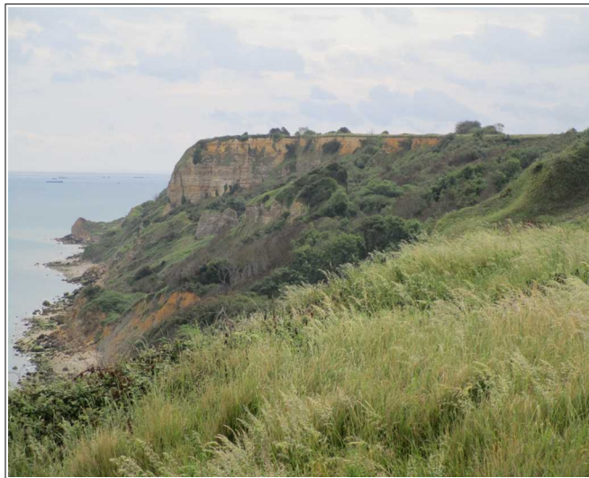
Figure 22: Vue générale de la zone chaotique du glissement de terrain du Bouffay.
