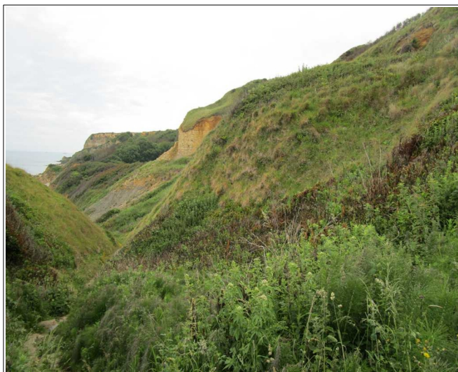
Figure 24: vue de la partie ouest du glissement de terrain du Bouffay.
