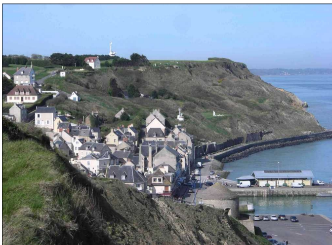
Figure 33: vue du chemin des Tourettes et des murs de soutènement le bordant.
