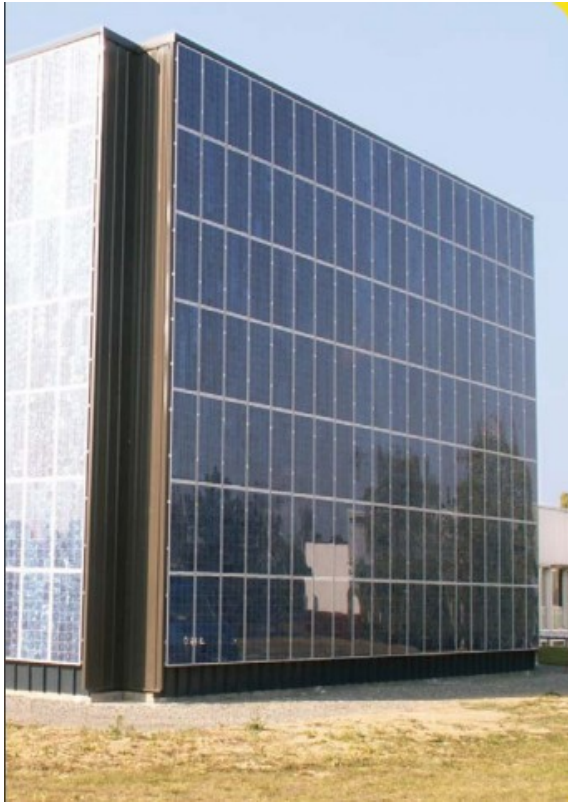
SAFT Power Systems à Chambray-les-Tours (37)
