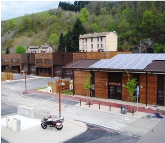
Pépinière d'entreprises de Tarare (69)
