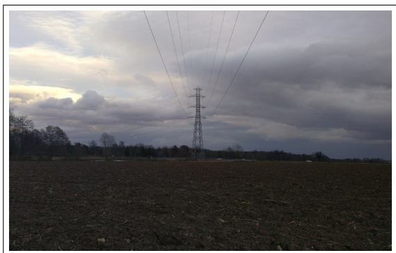
Support situé à 262m du point 0
