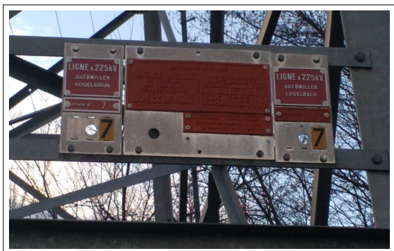
FIGURE 10 – Vue de la plaque signalétique, support 7
