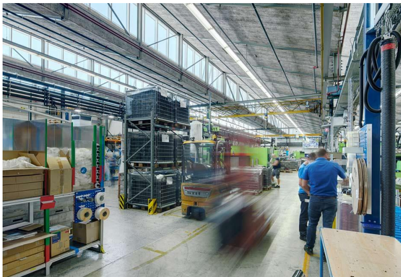
Exemple de bâtiment industriel avec SHEDS.
