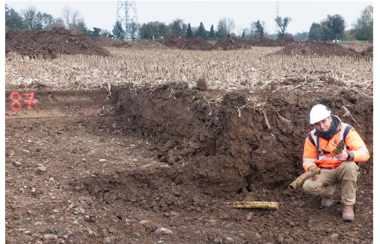
Fig. 9. Vue d'un drain sectionné au cours du creusement du sondage 87
