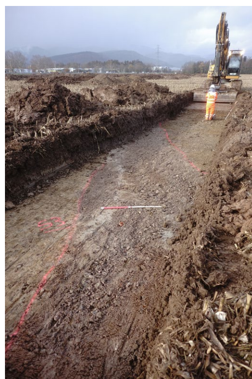
Fig. 51. Vue du bras d'eau 53 dans le sondage 343
