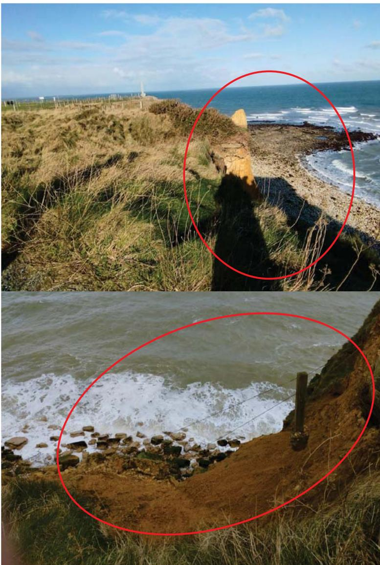
Photographie 9 : Glissements de terrains de la falaise observés sur le site – (Crédit photo : SOCOTEC - 2025)
