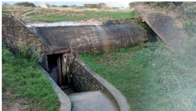
Figure 31 : Point de vue n°25, bunker, zone de saturation et d'obstacle.
