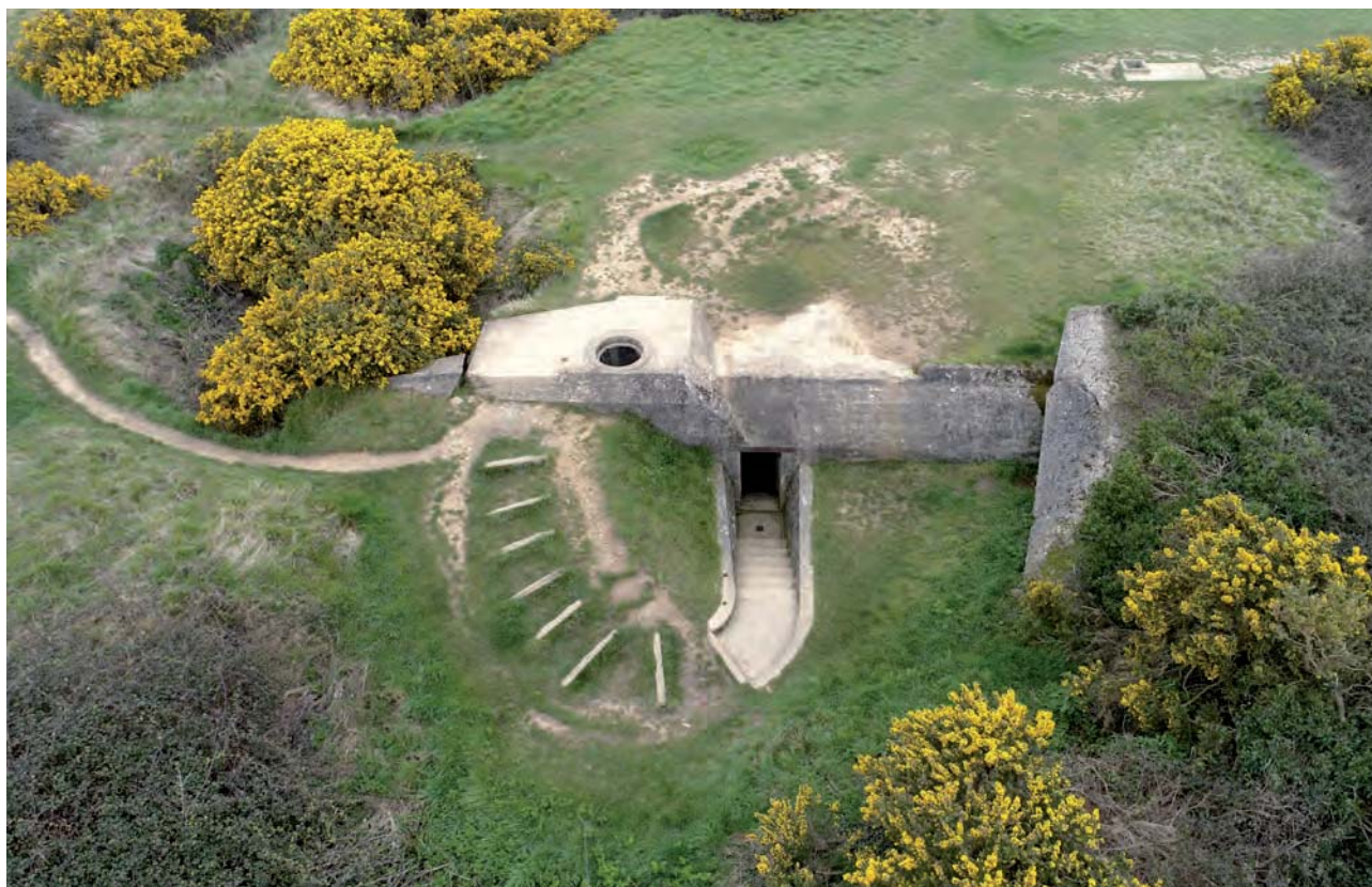
Fig. 59 Ouvrage bétonné n°19, abri modèle Regelbau 661 à usage d'infirmerie, construit en 1943. © Inrap 2019
