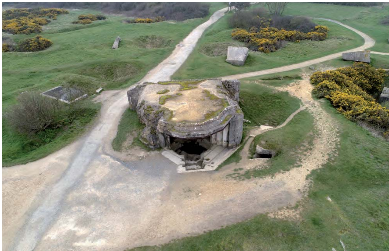
Fig. 56 Ouvrage bétonné n°17, casemate de tir pour canon de 155 mm modèle Regelbau 694, achevée le 6 juin 1944. © Inrap 2019
