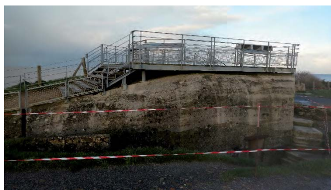
Figure 18 : Point de vue n°12, bunker, zone de saturation et d'obstacle.
