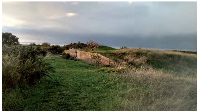
Figure 20 : Point de vue n°14, bunker, zone de saturation et d'obstacle.
