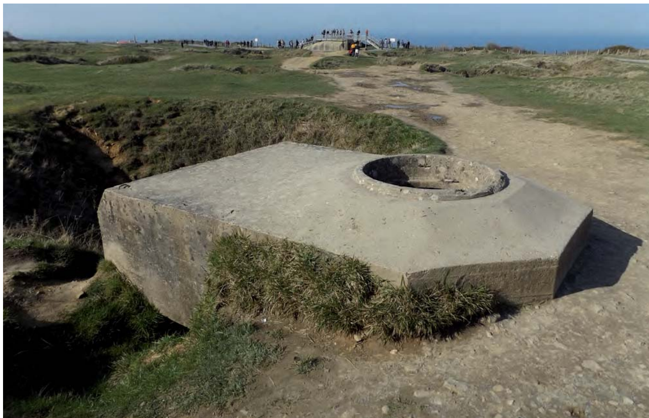
Fig. 37 Ouvrage bétonné n°1, Tobrouk modèle Bf. 58c, construit à la fin de l'année 1943. © Vincent Carpentier/Inrap 2019
