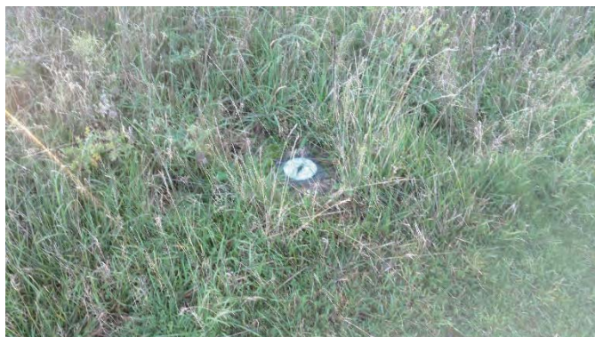
Figure 21 : Point de vue n°15, regard de canalisation, cible.
