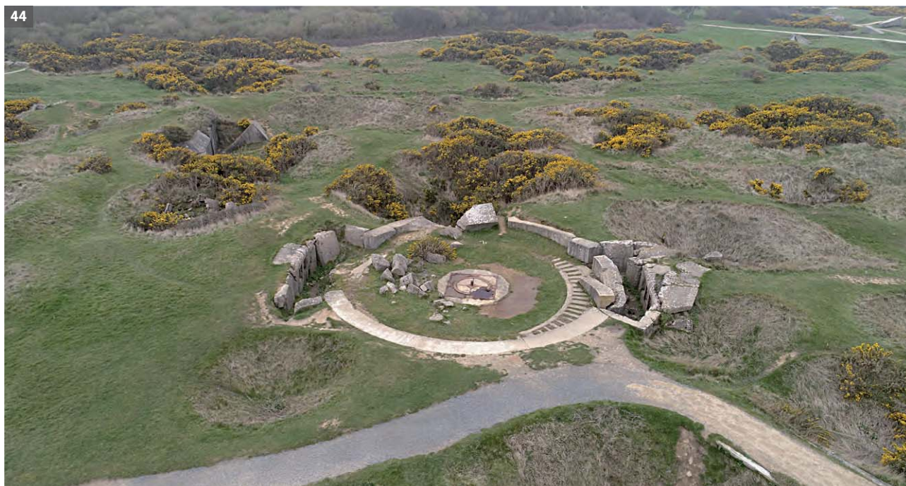
Fig. 45 Ouvrage bétonné n°6, base bétonnée et pivot central métallique destiné à accueillir une plaque rotative en acier pour canon de 155 mm. © Vincent Carpentier/Inrap 2019
