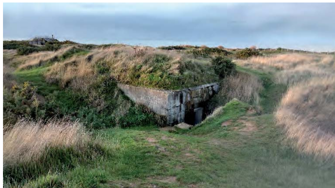
Figure 19 : Point de vue n°13, bunker, zone de saturation et d'obstacle.
