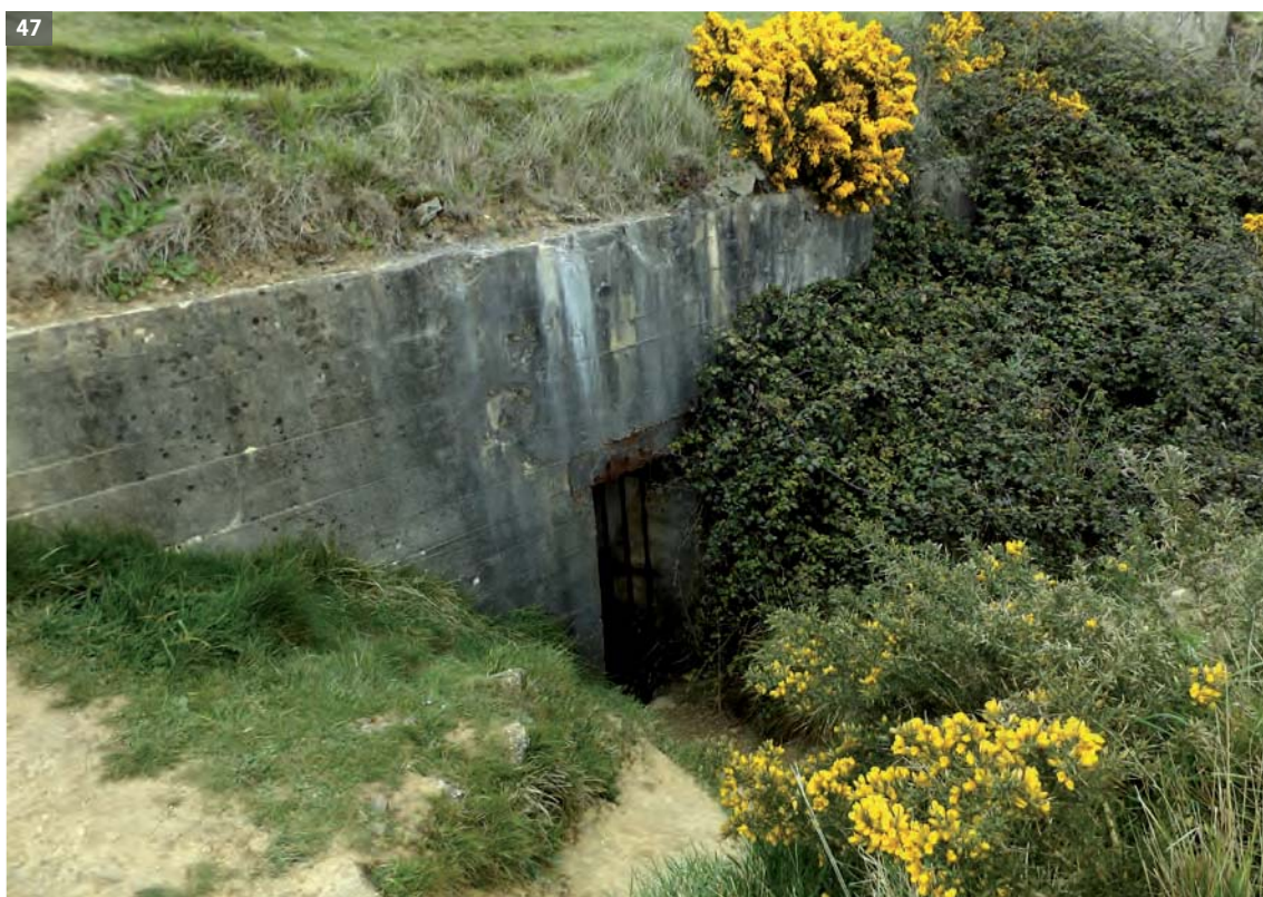
Fig. 47 Ouvrage bétonné n°8, abri pour deux groupes de combat modèle Regelbau 502, construit en 1942. © Vincent Carpentier/Inrap 2019
