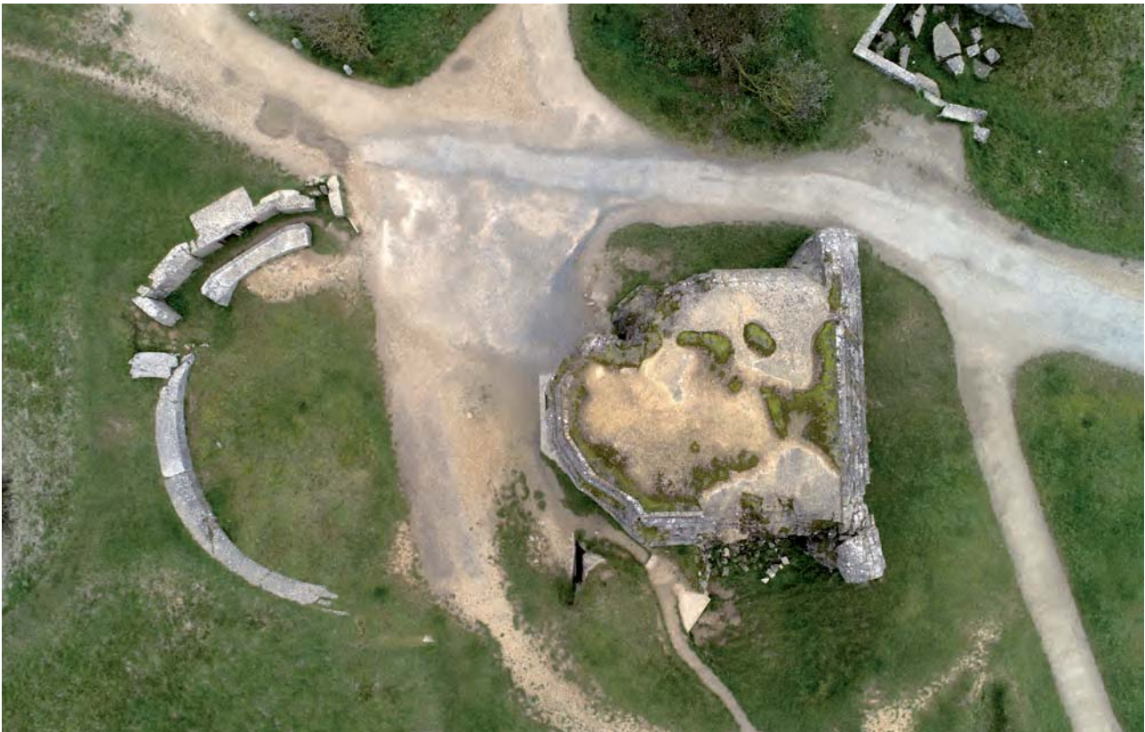
Fig. 55 Ouvrage bétonné n°16 (à gauche), encuvement circulaire semi-enterré pour canon de 155 mm, construit à partir de juillet 1942 et en partie démoli en vue d'être remplacé par la casemate de tir située à droite du cliché.
