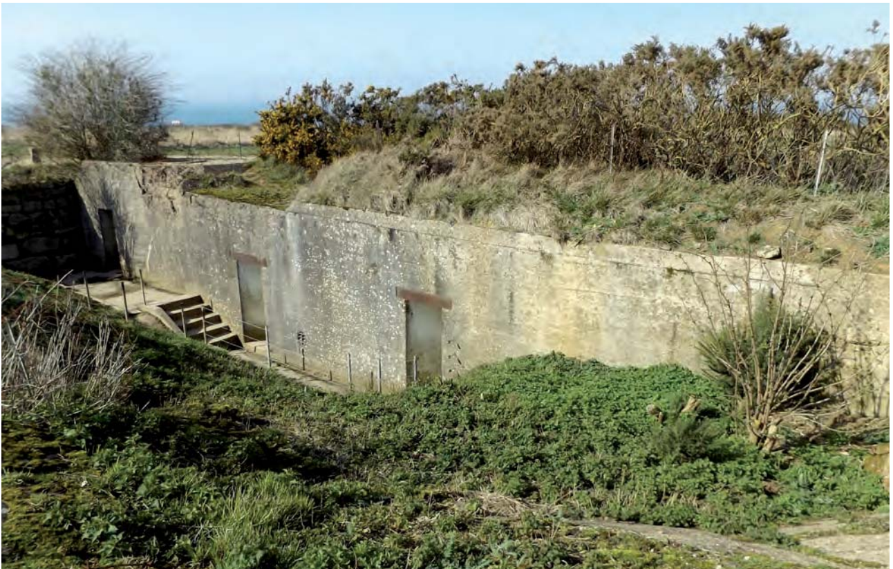
Fig. 54 Ouvrage bétonné n°15, abri pour deux groupes de combat modèle Regelbau 502, construit en 1942. © Vincent Carpentier/Inrap 2019
