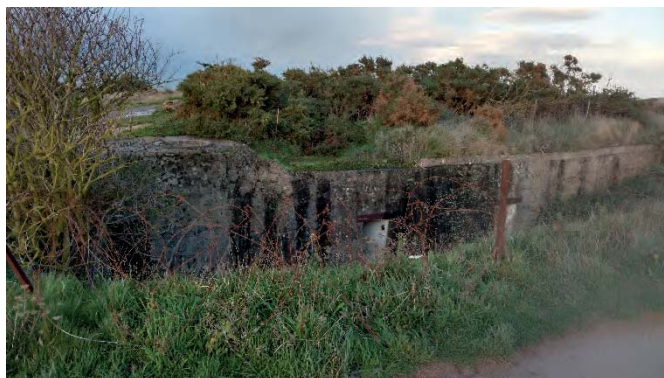
Figure 26 : Point de vue n°20, bunker, zone de saturation et d'obstacle.
