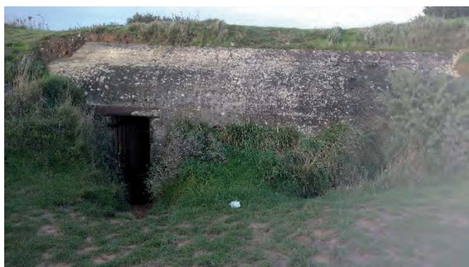
Figure 15 : Point de vue n°9, bunker, zone de saturation et d'obstacle.
