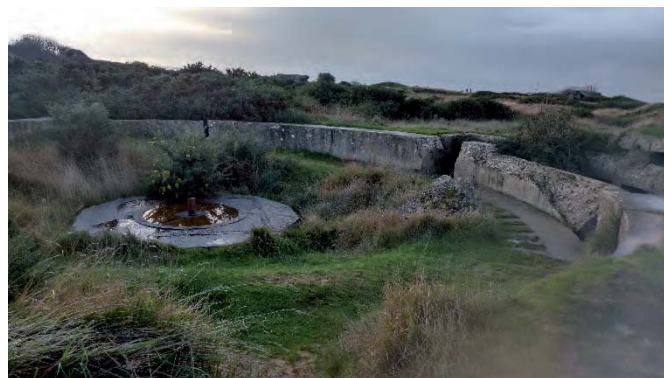
Figure 14 : Point de vue n°8, emplacement d'artillerie, zone de saturation et d'obstacle.
