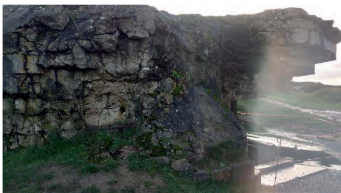
Figure 27 : Point de vue n°21, bunker, zone de saturation et d'obstacle.
