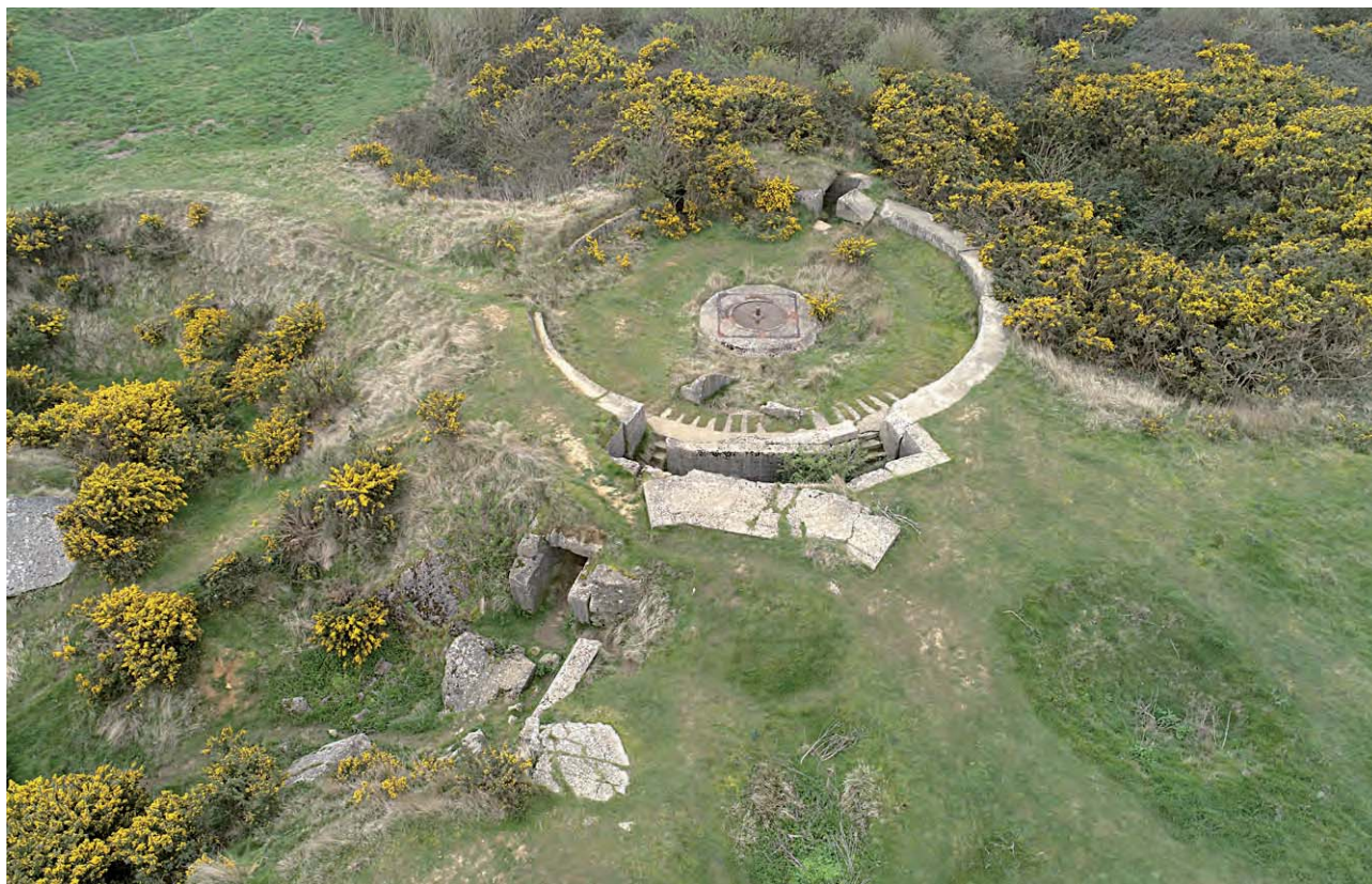
Fig. 38 Ouvrage bétonné n°2, encuvement circulaire semi-enterré pour canon de 155mm, construit à partir de juillet 1942. © Inrap 2019
