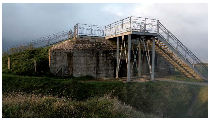
Figure 23 : Point de vue n°17, bunker, zone de saturation et d'obstacle.
