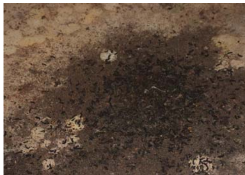
Guano dans un bunker
