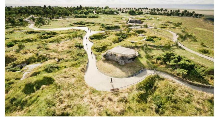
21 VUE D'ENSEMBLE CENTRALE
