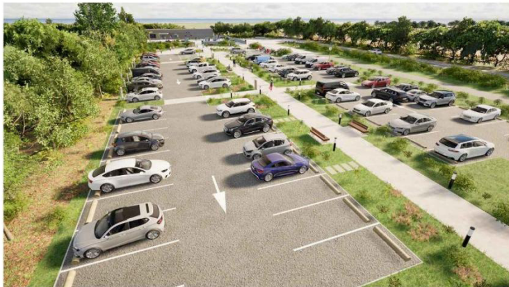
40 VUE D'ENSEMBLE STATIONNEMENT VOITURES
