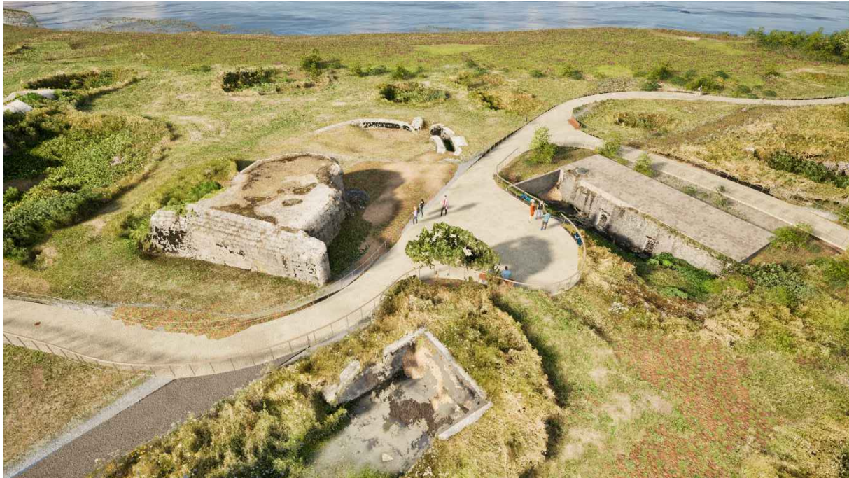
28 VUE D'ENSEMBLE BUNKER R502-2
