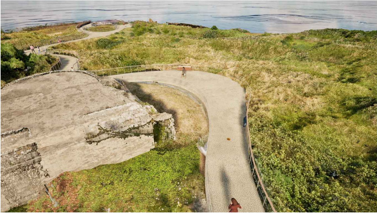
20 CASEMATE R694-3 VERS LE BUNKER R636-A
