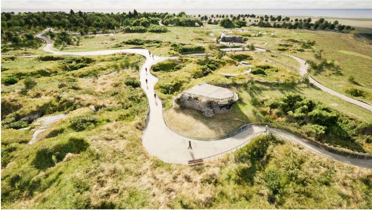
21 VUE D'ENSEMBLE CENTRALE
