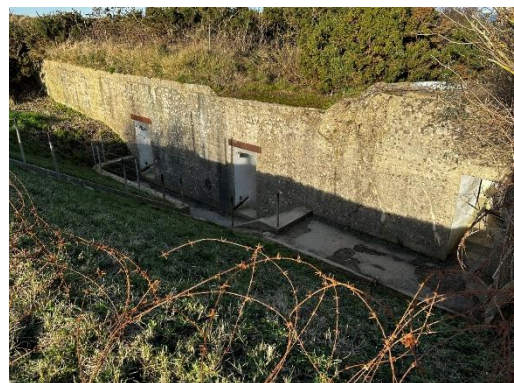
Figure 22 - Photographie du Bunker "R502-2"
