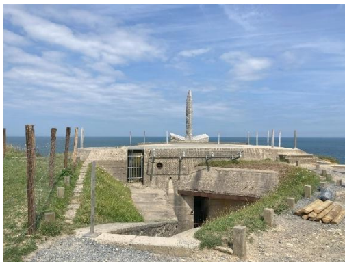
Figure 23 – Photographie du Bunker d'observation "R636-A"
